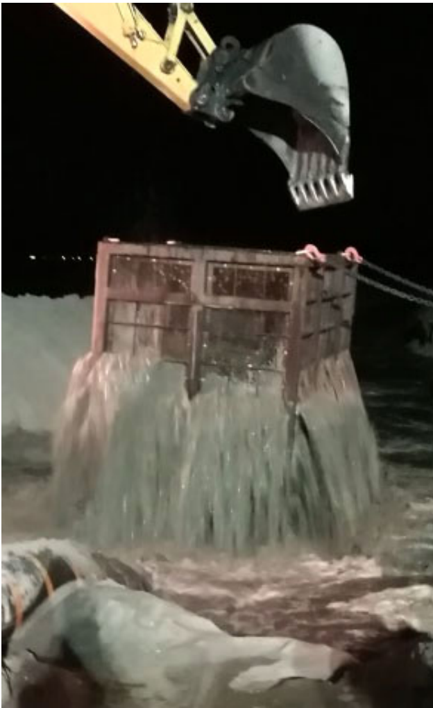
Abbildung 1.5: (links) Am Ende der Spüleleitung wird bei Strandaufspülungen für den Küstenschutz in MV ein Korb mit einer Maschenweite von 12 mm eingesetzt; (rechts) Beispielausbeute zurückgehaltener Kampfmittel (Fotos: Munitionsbergungsdienst Mecklenburg-Vorpommern, 2017).
