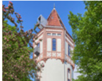
Wasserturm Kiel Wik, Kiel
