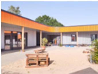
Kita Fuchsbau, Norddeich
