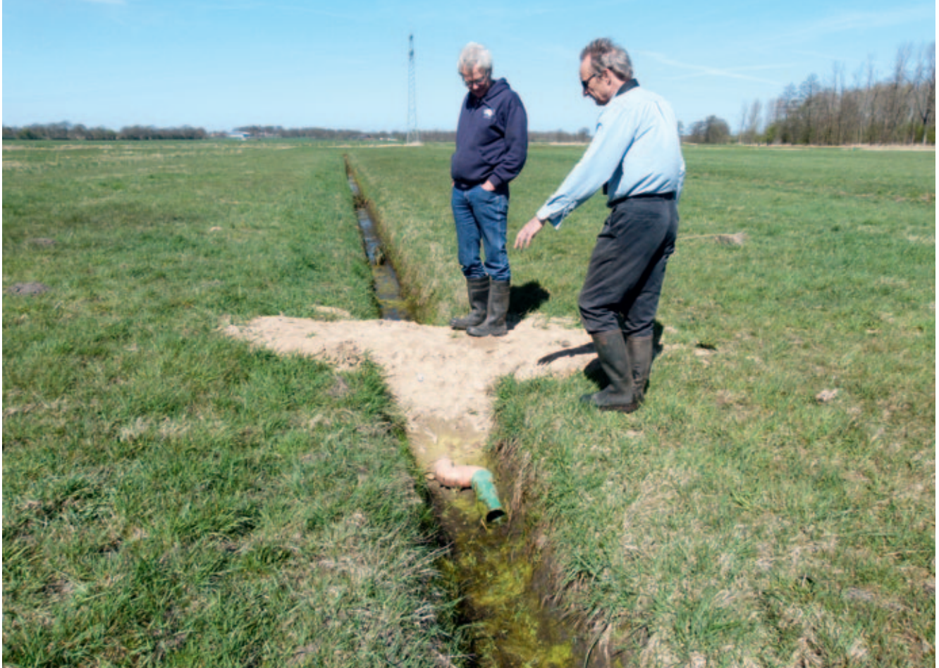
Abb. 1: Erdstau mit regulierbarem Knickrohr in einer Grütpe am 21.04.2015 Foto: DVL SH
