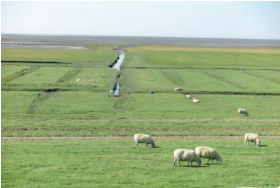
Abbildung 123: Deich und Vorland bei Wesselburen (Foto: B. Burbaum, LLUR)
