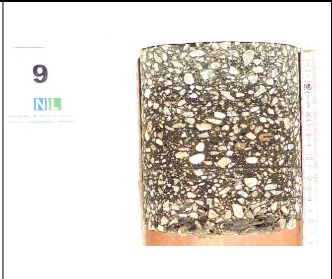
Bild 18: Mantelfläche Bohrkern R9
