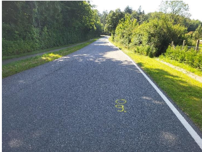
Bild 17: Entnahmestelle Bohrkern R9
