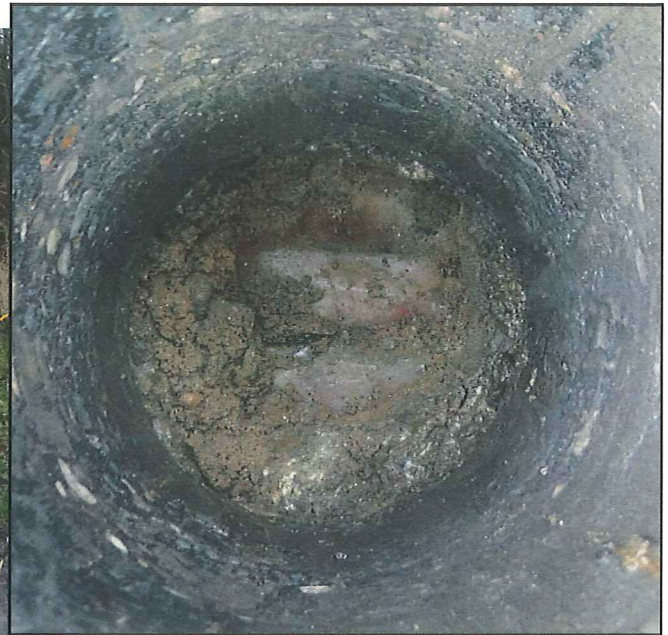
Oberfläche des Klinker-/Ziegelpflasters (29,5 cm unter OK Asphalt)
