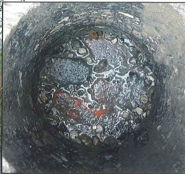
Oberfläche des Klinker-/Ziegelpflasters (20 cm unter OK Asphalt)
