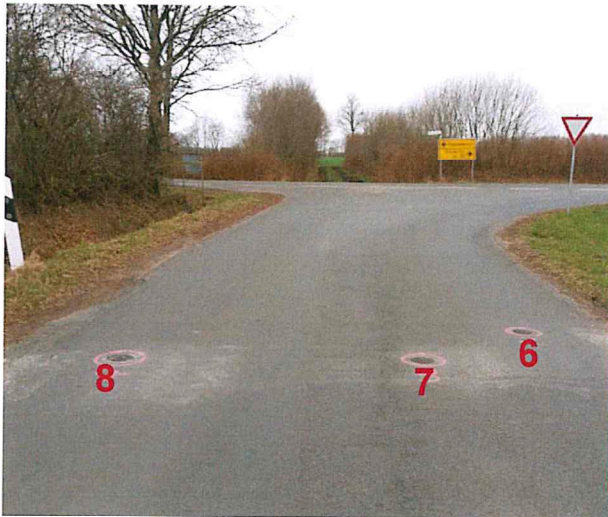
Bild 7: Entnahmestelle Bohrkern Nr. 8
