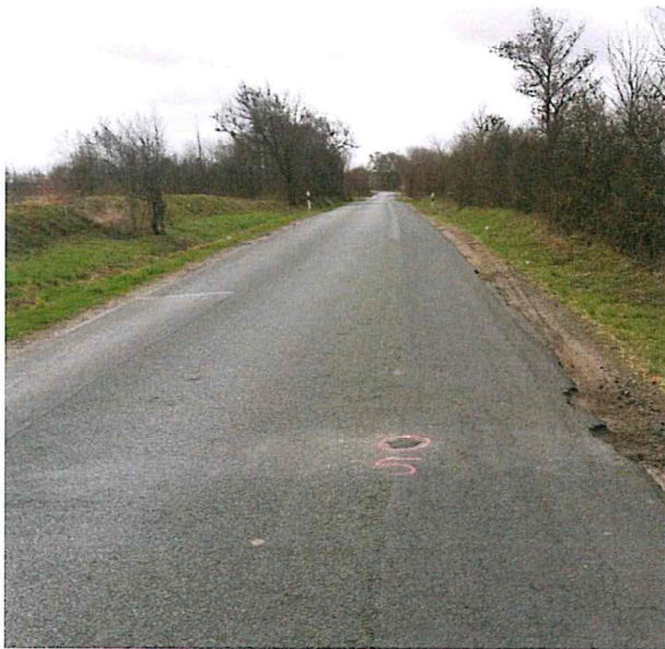
Bild 1: Entnahmestelle Bohrkern Nr. 5
