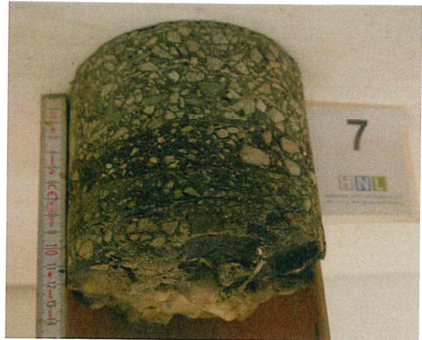
Bild 6: Mantelfläche Bohrkern Nr. 7
