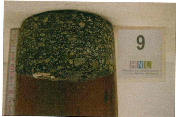
Bild 10: Mantelfläche Bohrkern Nr. 9
