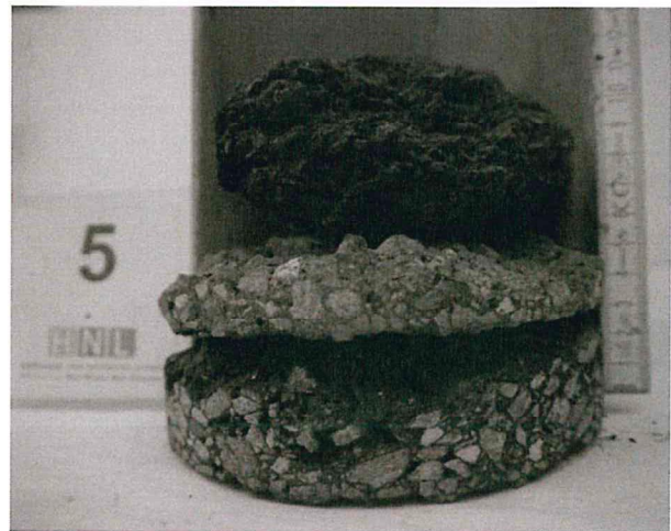
Bild 2: Mantelfläche Bohrkern Nr. 5
