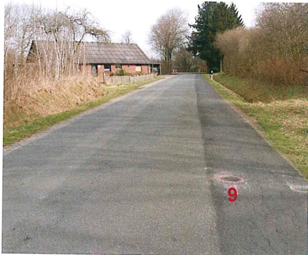
Bild 9: Entnahmestelle Bohrkern Nr. 9
