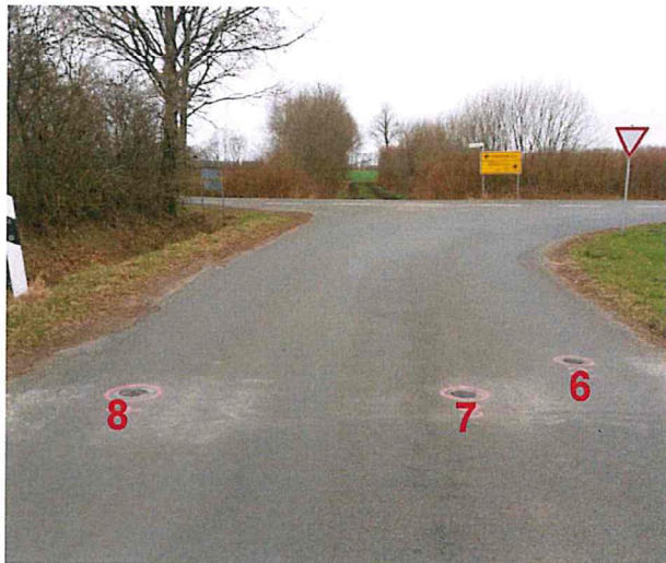
Bild 3: Entnahmestelle Bohrkern Nr. 6
