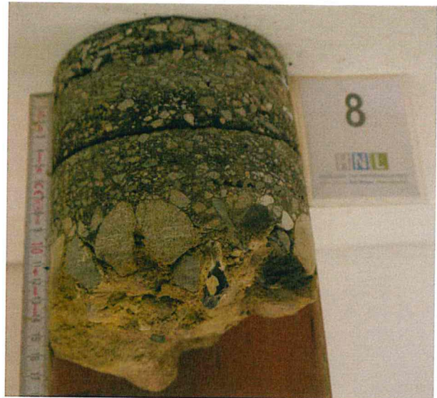
Bild 8: Mantelfläche Bohrkern Nr. 8
