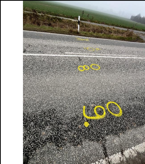
Bild 15: Entnahmestelle Bohrkern 8
