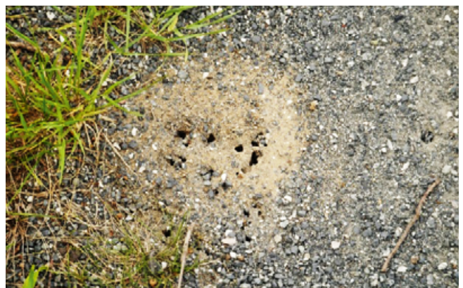
Abb. 36: Schaden durch Ameisen im Radweg an der L 100.
