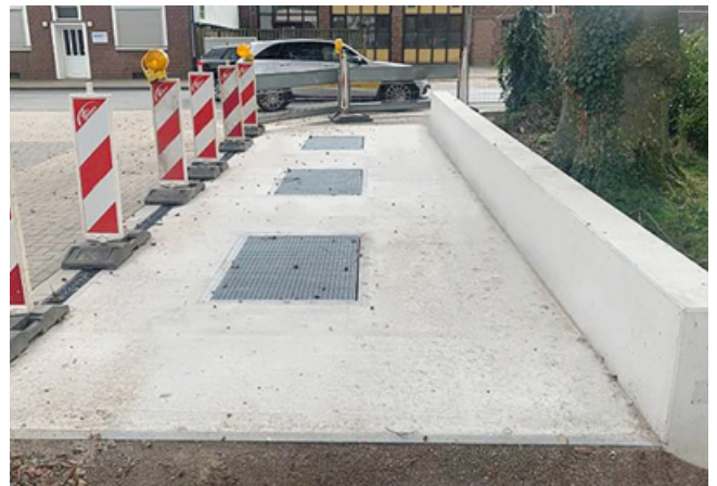
Abb. 16: Durchgehende Wurzelbrücke aus Beton mit integrierten Belüftungselementen.
