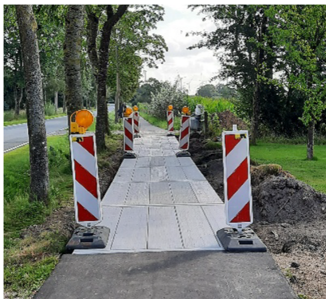
Abb. 54: Betonwurzelbrücken in dem Radweg an der L 212.
