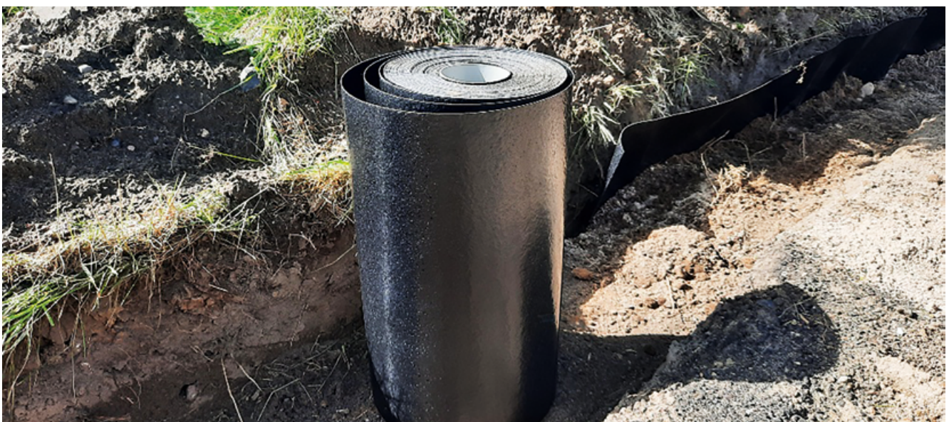
Abb. 55/56: Betonwurzelsperren in dem Radweg an der L 212.
