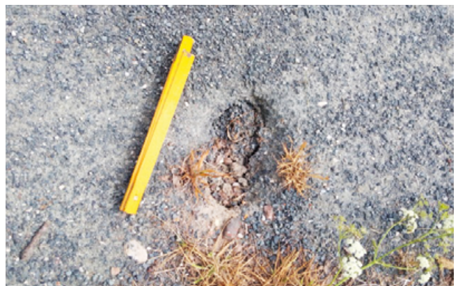
Abb. 35: Schaden durch Wühlmäuse im Radweg an der L 100.
