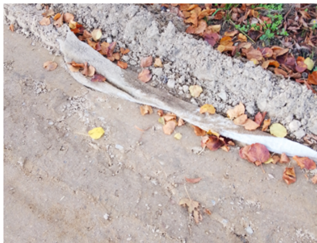
Abb. 32: Eingebautes Wurzelvlies
