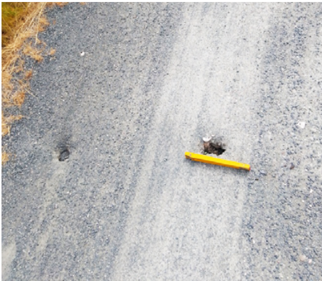
Abb. 37: Schäden durch Wühlmäuse im Radweg an der L 100.
