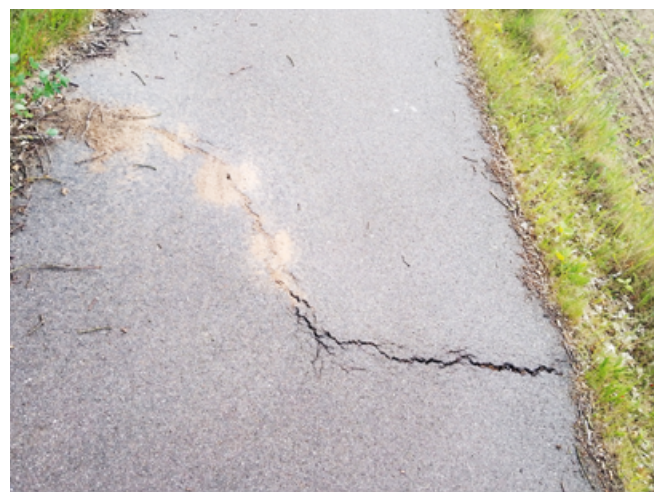
Abb. 39: Zustand des Abschnittes mit Asphaltdecke fünf Jahre nach der Instandsetzung.
