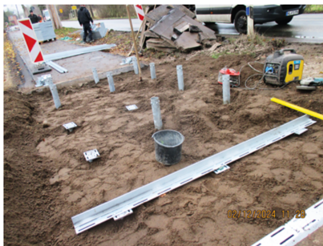
Abb. 65/66: Einbau der Wurzelbrücken aus Stahl an der L 309.
