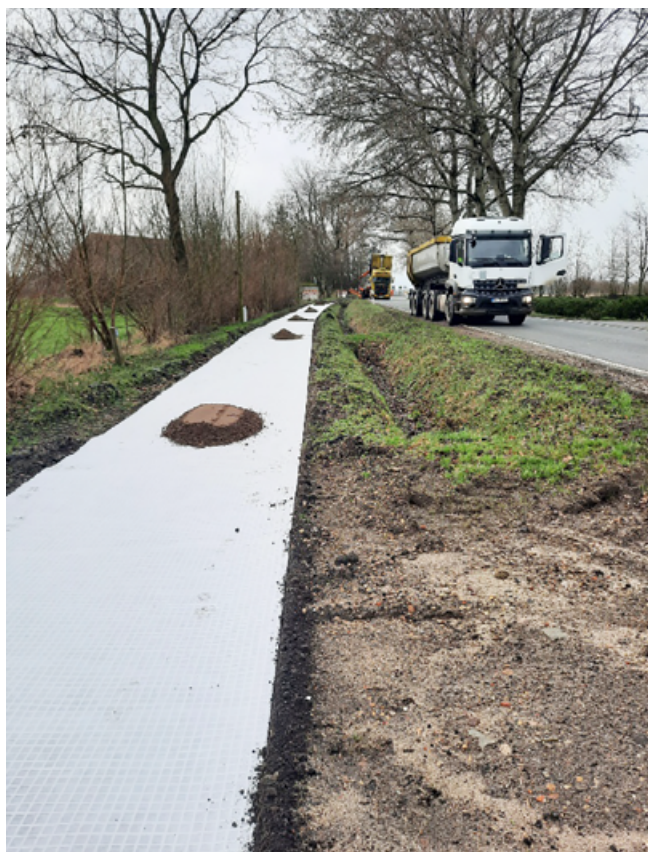
Abb. 53: Einbau des Wurzelvlies an der L 212.
