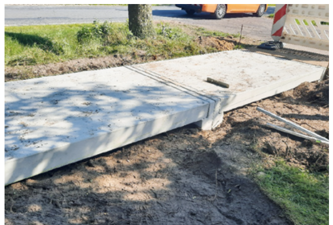
Abb. 17: Betonwurzelbrücke auf Betonstreifenfundamenten.
