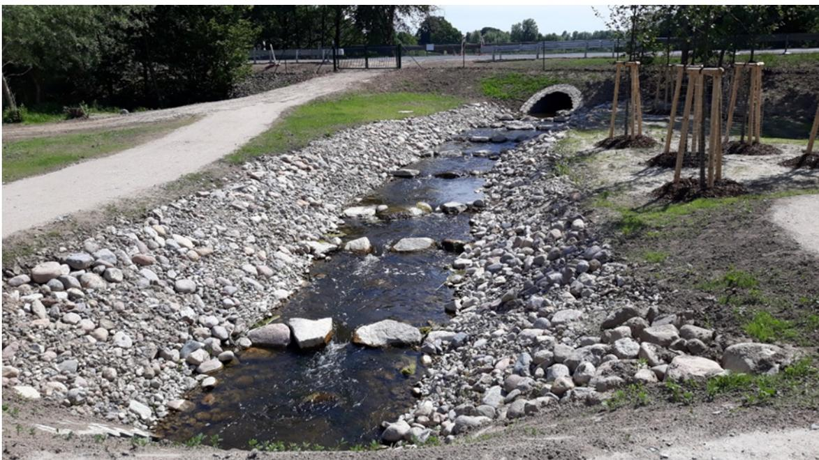
Abb. 13: Fischaufstiegsanlage Gottmannsförde nach der Bauabnahme (Dr. Kemsies, StALU Westmecklenburg)
