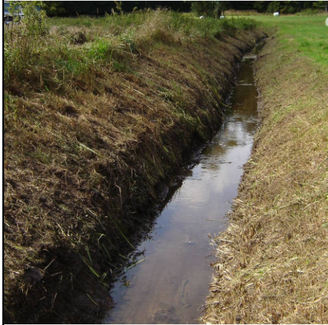
Beschädigte Sohle und Böschungsfüße
