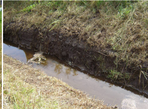
Beschädigte Sohle und Böschungsfüße
