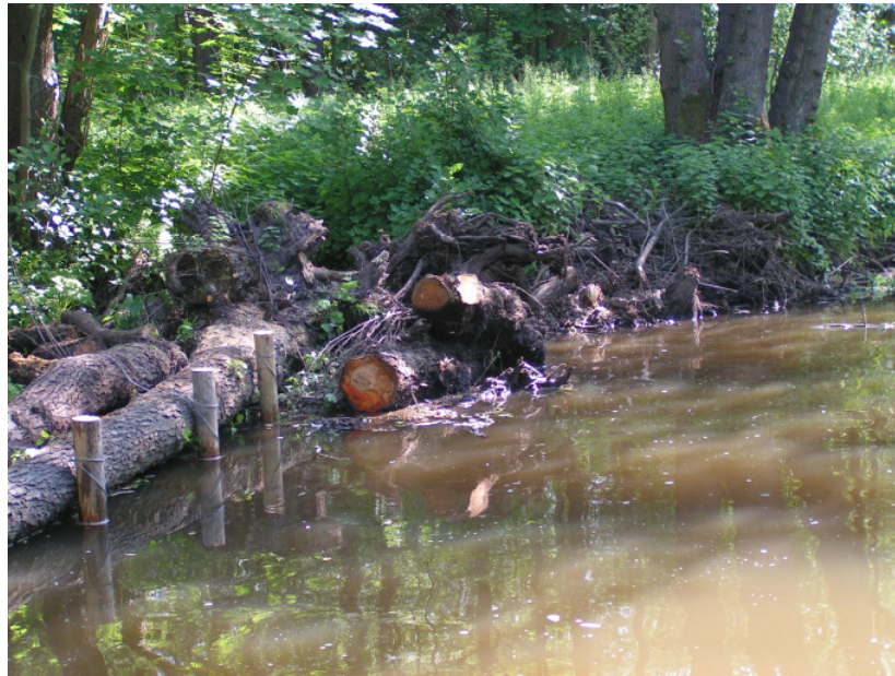
Ein umgestürzter Baum ist am Ufer eingebaut worden.
