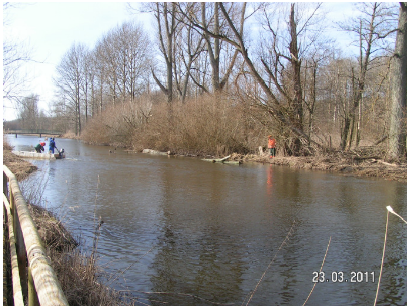
Der umgestürzte Baum wurde als Abflusshindernis beseitigt aber als strukturverbesserndes Element am Ufer eingebaut.
