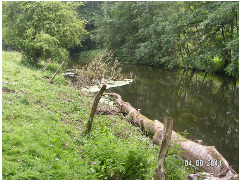
Einbau von Totholz zur Stabilisierung der Böschung.
