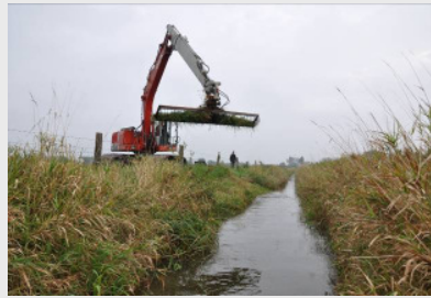
Mähen der Böschung auf der Arbeitsseite ( ohne Uferbereich), Ablegen des Mähguts...
