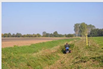
Mahd der oberen Uferböschung mit Frontmäher
