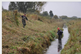
Abschnittsweise Mähen des Böschungsüberhangs und Krauten von ca. 1/3 der Sohle mit Handsense und Entnahme des Mähguts (d. h. kein Seitenmähereinsatz im unteren Uferbereich)
