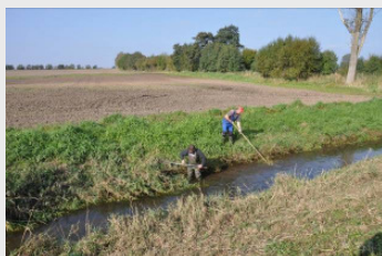
Abschnittsweise Mähen des Böschungsüberhangs und Krauten von ca. 1/3 der Sohle mit Handsense und Entnahme des Mähguts (d. h. kein Seitenmähereinsatz im unteren Uferbereich)
