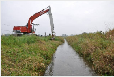
Mähen der Böschung auf der Arbeitsseite ( ohne Uferbereich), Ablegen des Mähguts...
