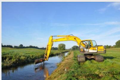
In einem Arbeitsgang: Krauten der Sohle auf der Arbeitsseite ca. ab der Mitte...
