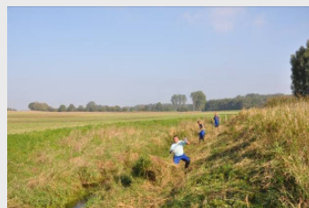
Mahd der unteren Böschung mit Handsense und Entfernen des Mähguts von der Böschung
