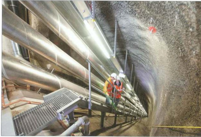
Bild 4. Der wintersicher, über eine Treppe begehbare, 155 m lange und 42° steile Stollen: Der Blick vom Abspannbauwerk nach unten vermittelt einen Eindruck, wie steil der Stollen verläuft; gasisolierte Leitungen sind hier besonders gut geeignet, weil sie im Gegensatz zu Kabeln in jedem beliebigen Winkel verlegt werden können
