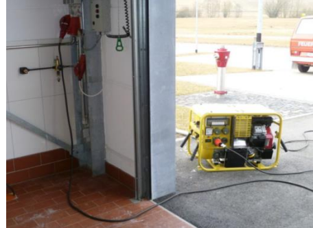
Abbildung 3 Einspeisung mit einem tragbaren Stromerzeuger über die Einspeisestelle in die elektrische Anlage des Feuerwehrhauses in Münchhausen nach Quelle [4]
