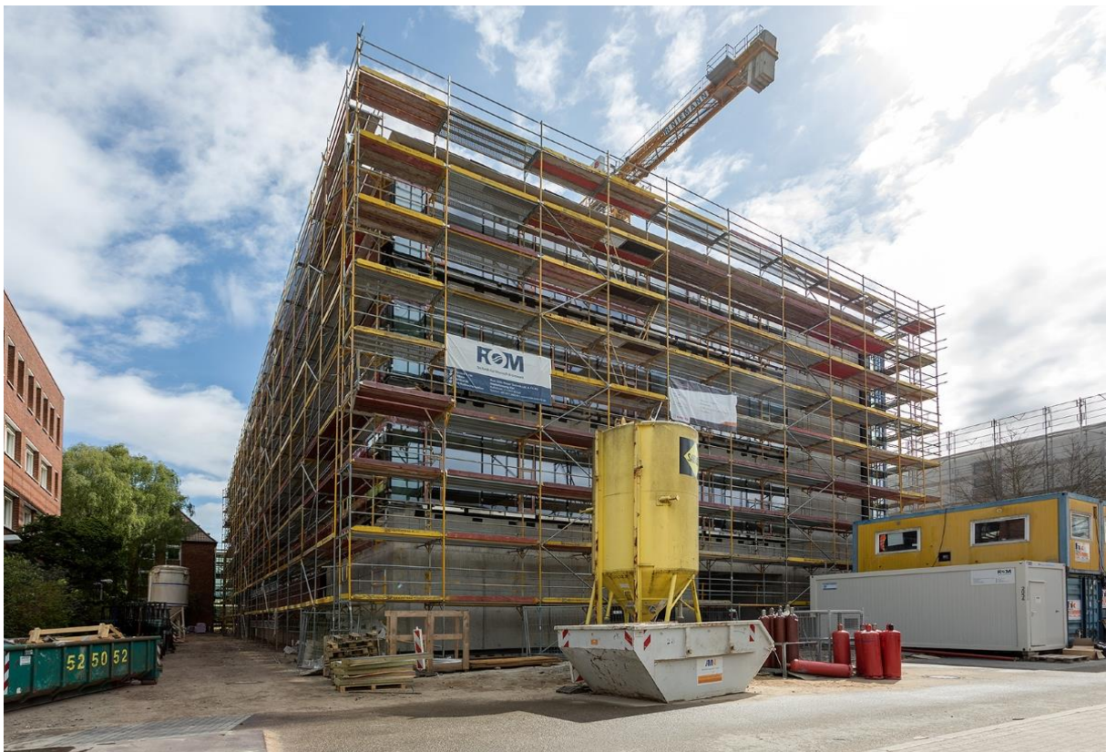
Neubau kriminaltechnisches Institut im Polizeizentrum Eichhof in Kiel
