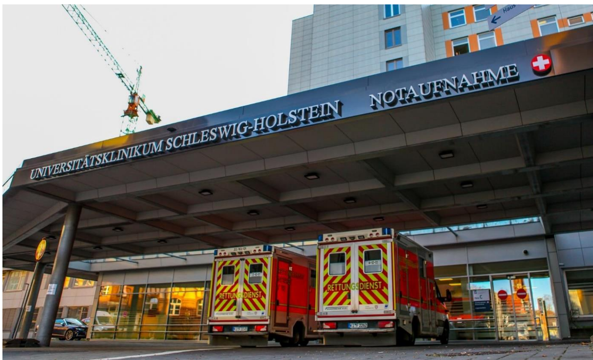
Umbau Interdisziplinäre Notaufnahme UKSH Kiel
