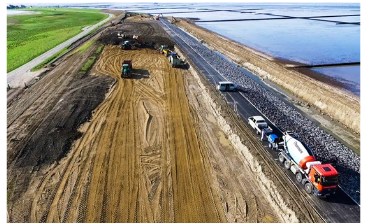
Hier erfolgt alles gleichzeitig: Der Rückbau des Kajedeichs, der Einbau des Kleis und die Verklammerung des Deckwerks.
