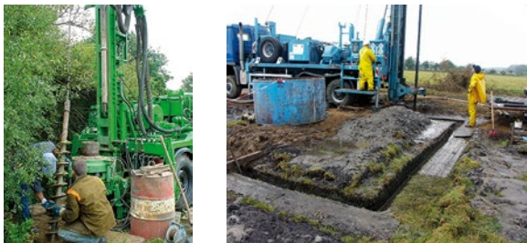
Trockenbohrung (li.): Die Bohrschnecke wird in das Bohrloch eingeführt. Spülbohrung (re.): Bohrgerät mit Spülungsrinne.
