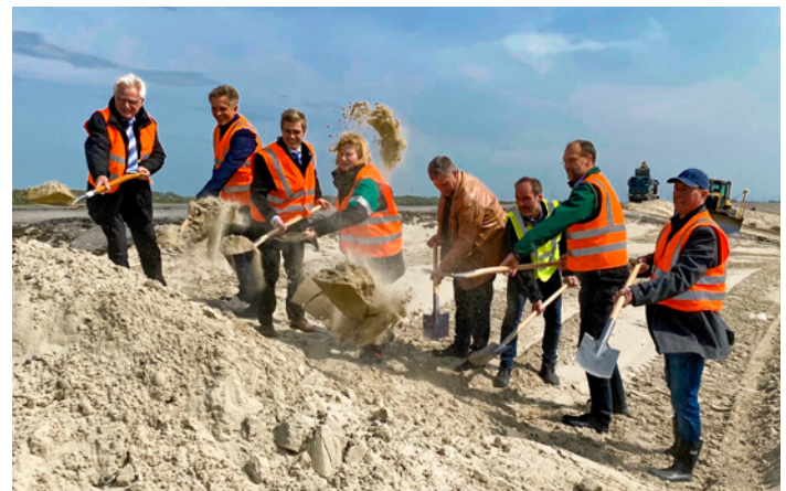
Spatenstich - gemeinsamer Start der Bauarbeiten, um in drei Jahren mit einem verstärkten Deich mehr Schutz für das Hinterland zu bieten.
