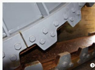
Ⓞ Der Leitstand ist rund um die Uhr mit einem Brückenwärter besetzt. Ⓞ+Ⓞ Die Brücken klappen nicht nur, sie rollen auch ein Stück auf riesigen Zahnrädern.
