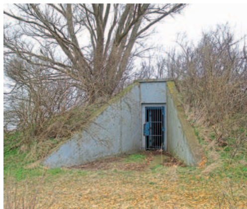
30 Sperrmittelhaus in Großenbrode-Heinrichsruh.
