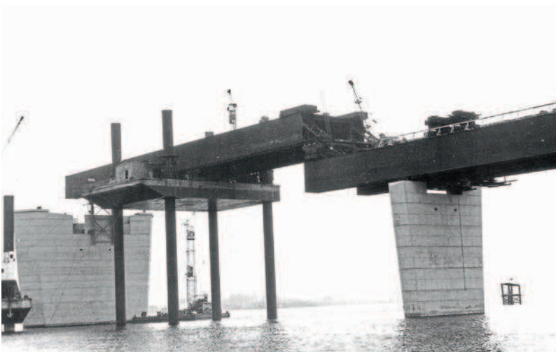
20 Überschieben des zweiten Nebentragwerks für die Montage zwischen Pfeiler 1 (rechts) und Pfeiler 2 (links), dazwischen die Hubinsel 5. Auf dem Festlanddamm ist bereits die Montage des dritten Tragwerks zu erkennen.
