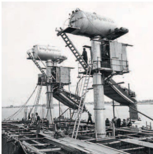
12 Stahlsenkkasten für Pfeiler 1 mit den beiden Einstiegsrohren der Druckluftschleusen.
