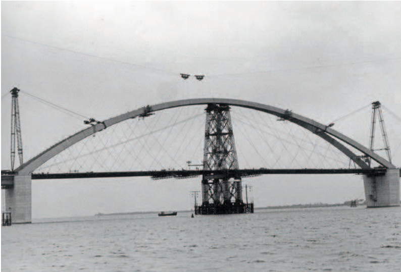
28 Die letzte Fahrbahnplatte ist am 30.11.1962 eingelegt, die Brücke damit geschlossen, die Seile sind noch nicht gespannt.
