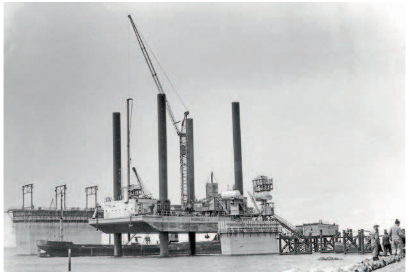
18 Hubinsel 4 zwischen Pfeiler 7 und dem Versorgungsschiff, links Pfeiler 6.
