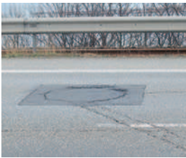
29 Ehemaliger Spreng- bzw. Sperrschacht in der Brückenauffahrt.
