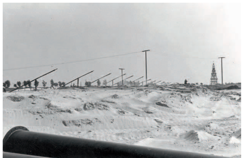
7 Berieselungsanlage der Festlandsrampe, im Vordergrund ein Spülrohr, im Hintergrund der Vermesungsturm in Größenbrode.
