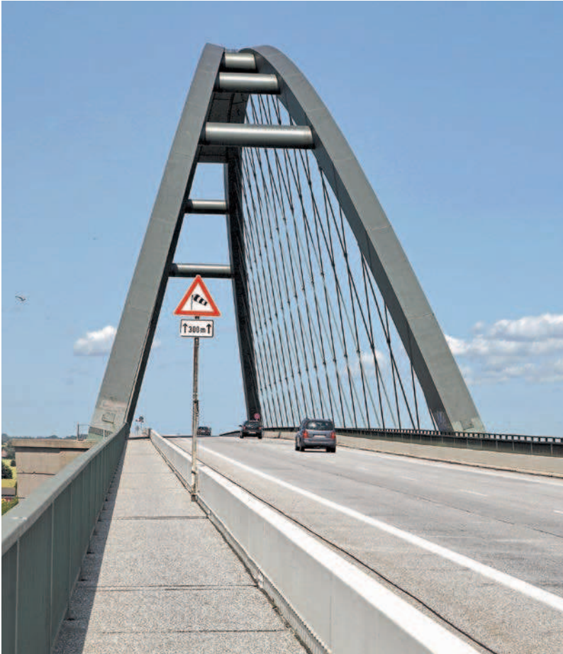
2 Fehmarnsundbrücke, Blick Richtung Fehmarn.
