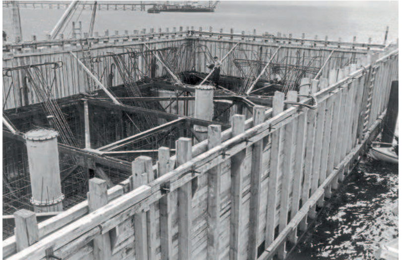
12 Stahlsenkkasten für Pfeiler 1 mit den beiden Einstiegsrohren der Druckluftschleusen.
