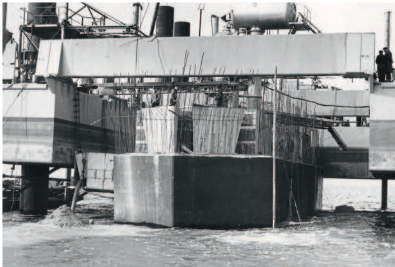
16 Hubinsel 3 mit dem künftigen Pfeiler 5 in ihrem hufeisenförmigen Einschnitt.
