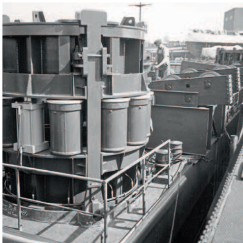
17 Hubinsel 5 mit der Hubvorrichtung eines Beines, im Hintergrund Rollenwagen.
