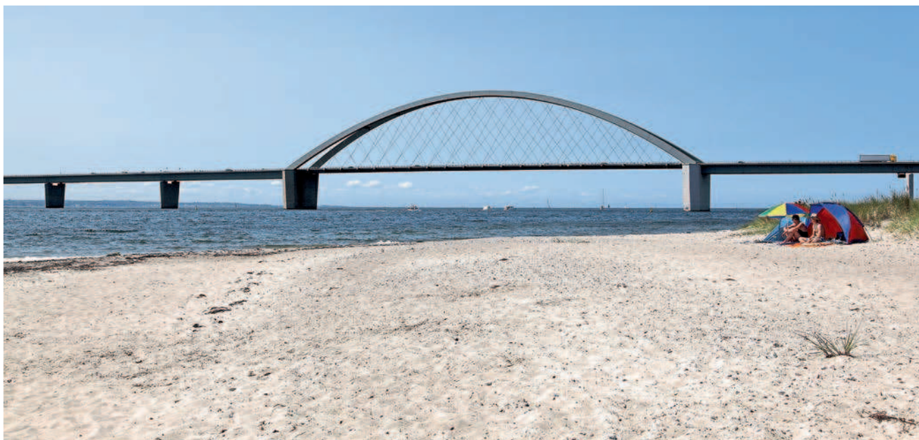
31 Das Netzwerk der Fehmarnsundbrücke.
