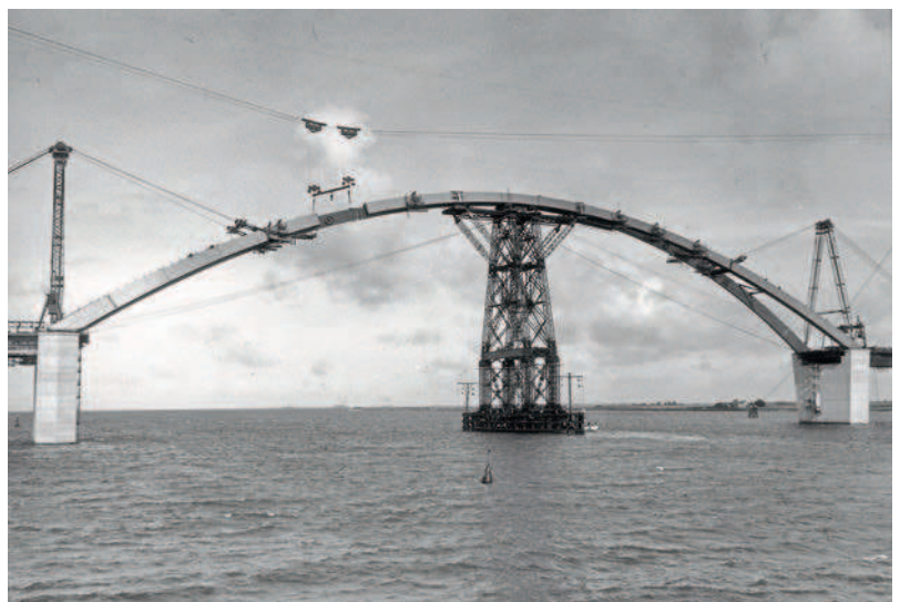
25 Das erste Kämpferstück auf dem Pfeiler 5, Aufschweißen eines Mastfußes für einen der Abspannmasten.
