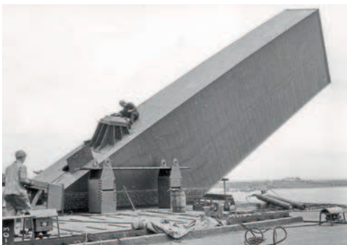
25 Das erste Kämpferstück auf dem Pfeiler 5, Aufschweißen eines Mastfußes für einen der Abspannmasten.
