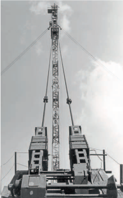
23 Gittermast für die Aufnahme eines Kabelkrans, seitlich zu Dalben abgespannt. Im Vordergrund die Nackenzugverankerung.
