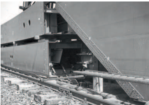
24 Zwei fertige Kasten-elemente der Bogenteile mit Löchern zur Aufnahme der Spannseile, rechts ein Kämpferstück.
