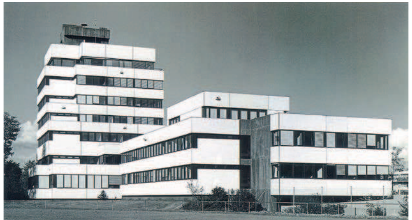
2 Rathaus Ansicht von Südwesten nach Fertigstellung.
