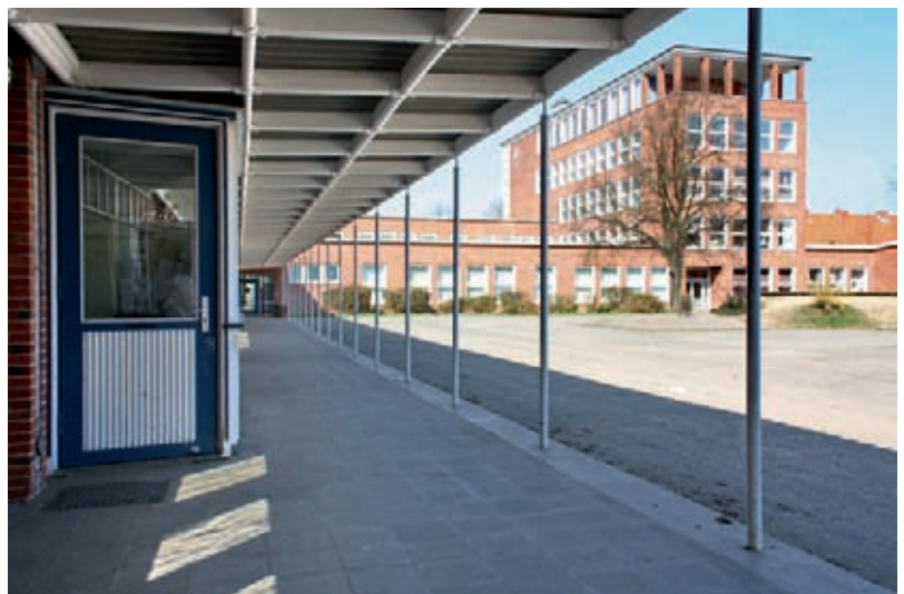
18 Theodor-Storm-Schule. Blick vom einseitig geschlossenen Verbindungsgang über den Pausenhof zum Fachklassenturm. Links der obligatorische Milchpavillon.
