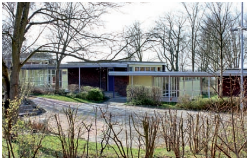
16 Andreas-Gayk-Schule in der Tiefe Allee. Blick über den Pausenhof zu den Pavillonklassen in Richtung Förde. Es zeigt sich die deutliche Berücksichtigung des Geländeprofiles bei der Gestaltung der Schule.
