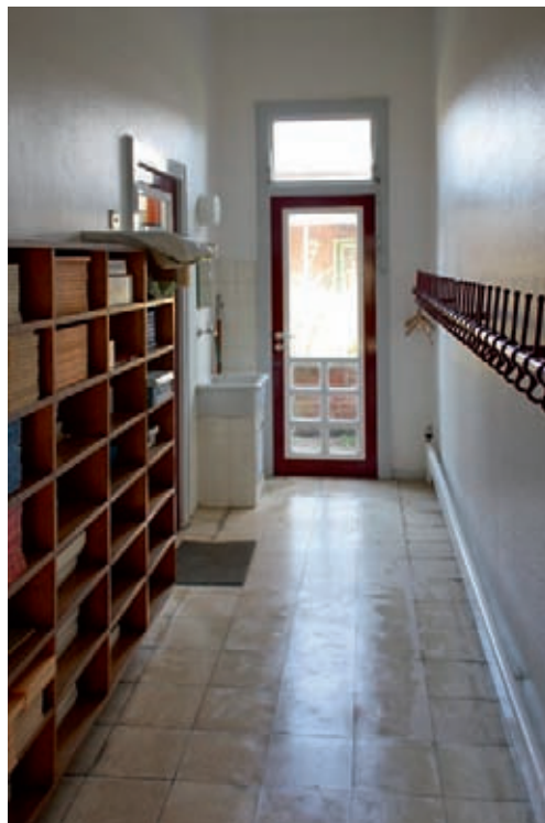
7 Friedrich-Junge-Schule. Garderobenraum mit den Zugängen zum Klassenraum und zur Freiluftklasse, rechts die Garderobenhaken mit dem zugehörigen Heizungsrohr, links die Schülerfächer.
