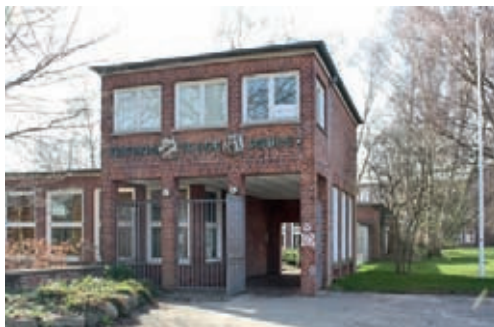
4 Friedrich-Junge-Schule in der Langenbeckstraße, Haupteingang mit dem zurückliegenden Fachklassenturm, dessen Uhrenturm die Blickachse der Langenbeckstraße bestimmt, heute durch Bäume verdeckt.
