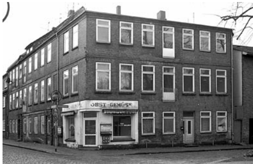
17 Kirchenstraße 1. Die unansehnliche Altbebauung.
