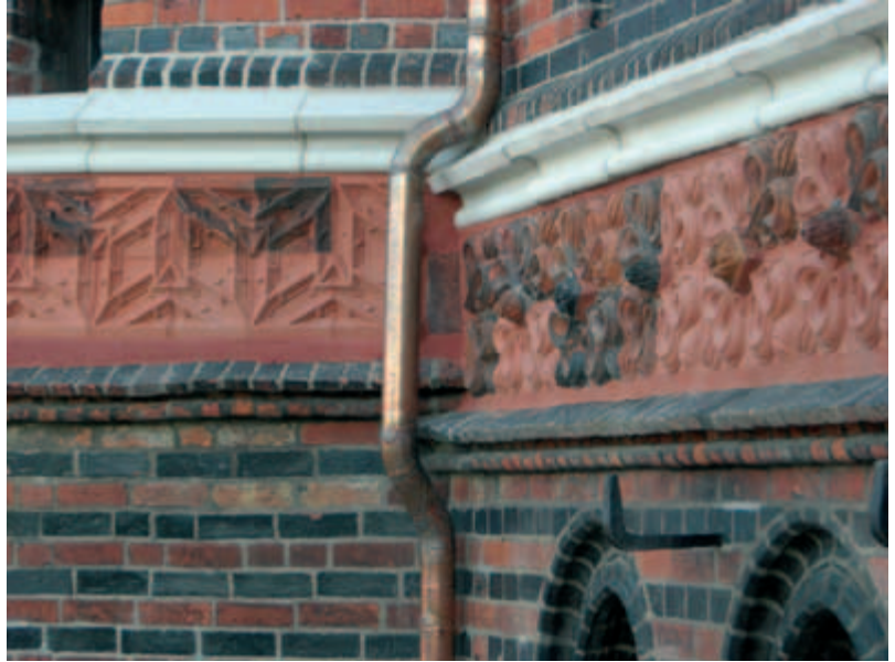
10 Ausschnitt des feldseitigen Mittelfrieses nach dem Wiedereinbau.
