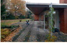
Das Becken vor der Sanierung (links) auf der Terrasse.
