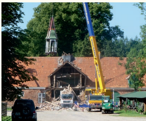
Mit einem Hebekran wird zunächst die Laterne geborgen.
