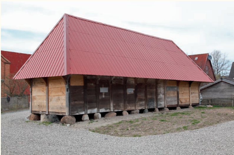
Der Bohlenspeicher in Stakendorf nach der Sanierung.
