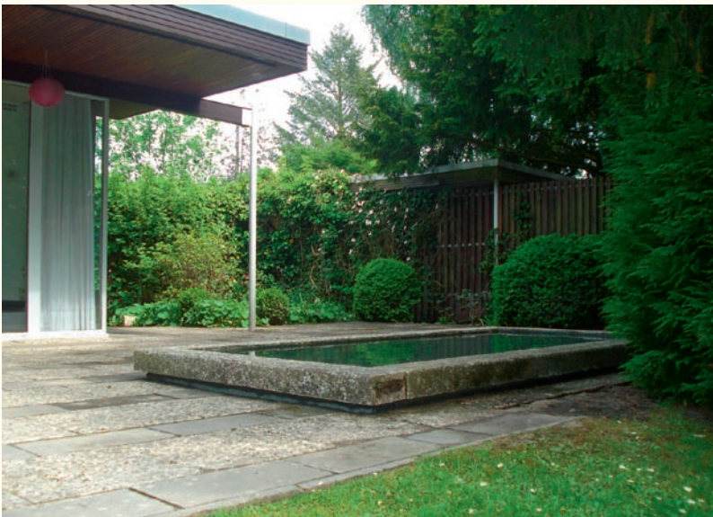
Nach der Wiederherstellung des Wasserbeckens (Max Plauen).
