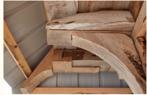
Detail der Zimmererarbeit im Balkenkopfbereich.
