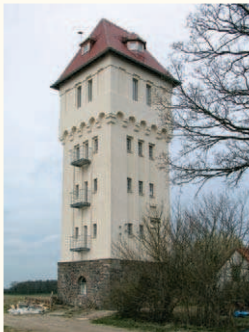
Weithin sichtbar: Wasserturm nach der Instandsetzung.
