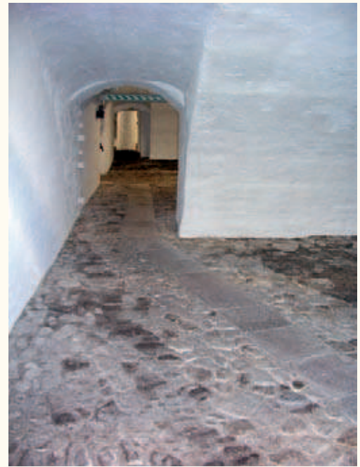
Kellerraum unter Schloss Gottorf mit überdecktem Abwasserkanal.
