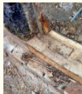
Eine seltene Hakenblattver- zahnung in der Schwelle.
