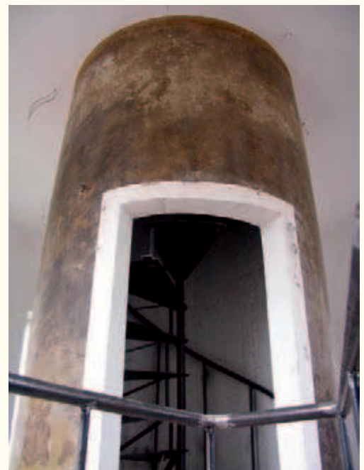
Aufstieg in den Wasserbehälter; heute Bad.
