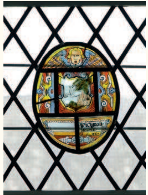
Eine ovale Wappenscheibe von 1622 nach Malschichtfes-tigung und Ergänzung (Fa. Peters, Paderborn).
