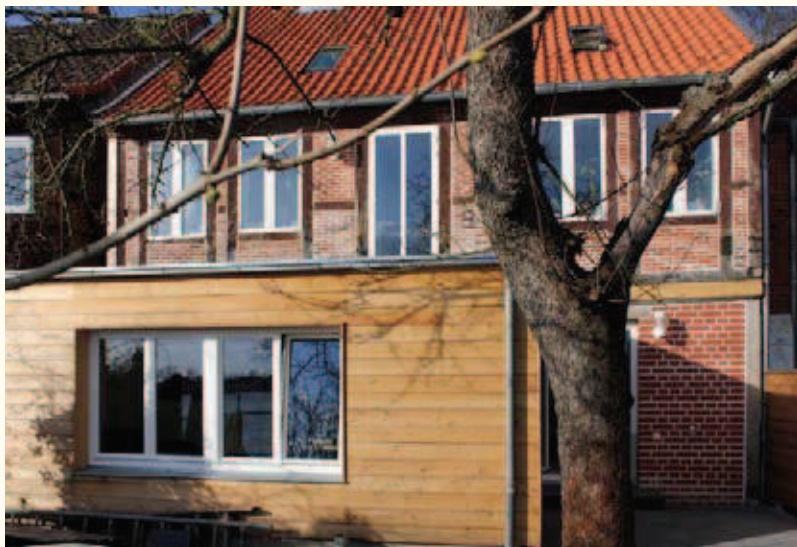
Die Elbseite des Hauses mit dem holzverkleideten Anbau der 1950er Jahre.
