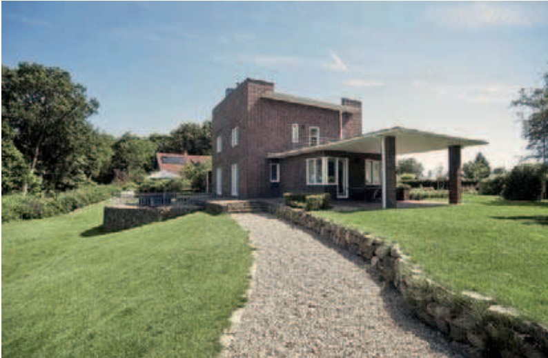
Haus Seekamp mit wiederhergestellten Außenanlagen.
