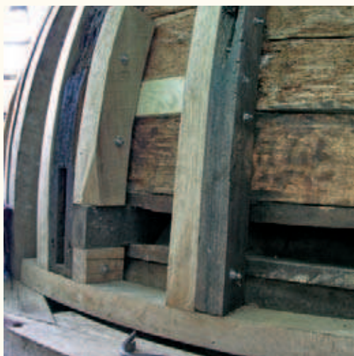
Reparaturen am Tragwerk der Kuppel.
