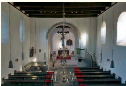
Der mit Gipsmörtel verputzte und gekalkte Innenraum in verbesserter Aufteilung mit vorgezogenem Altartisch und seitlich gestellter Taufe.
