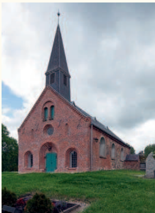
Die Kirche Vollerwiek aus Südwest mit sanierter Fassade.
