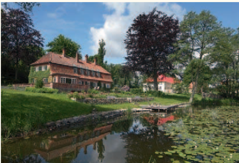
Mühlenensemble in Manhagen, links das sogenannte „Englische Landhaus“ mit vorgelagerter Gartenterrasse.
