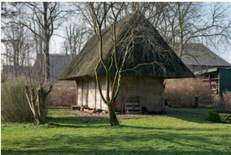
Der Barsbeker Bohlenspeicher nach der Sanierung.
