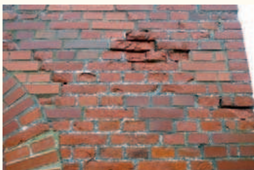
Mauerwerk der Westfassade vor der Sanierung mit Frostschäden.
