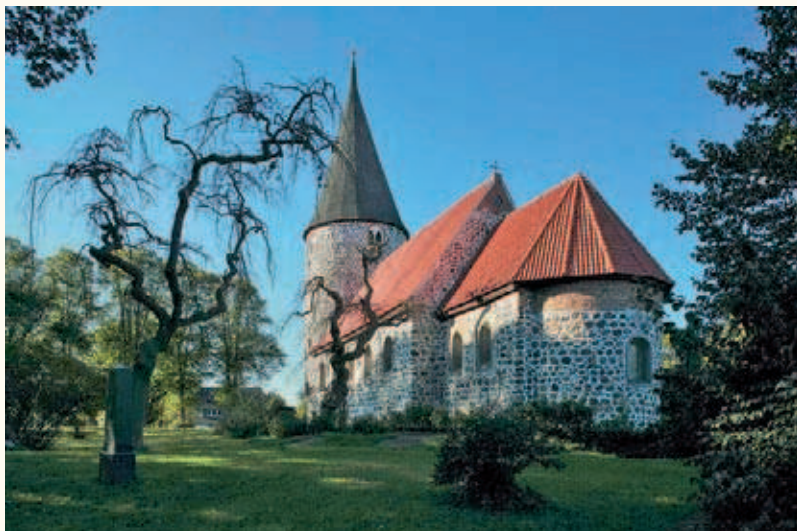
Der „schiefe“ und ausbauschende Rundturm in Ratekau wurde durch Holzfelgenreine und Vernadelung gesichert (Ing. Gladigau).
