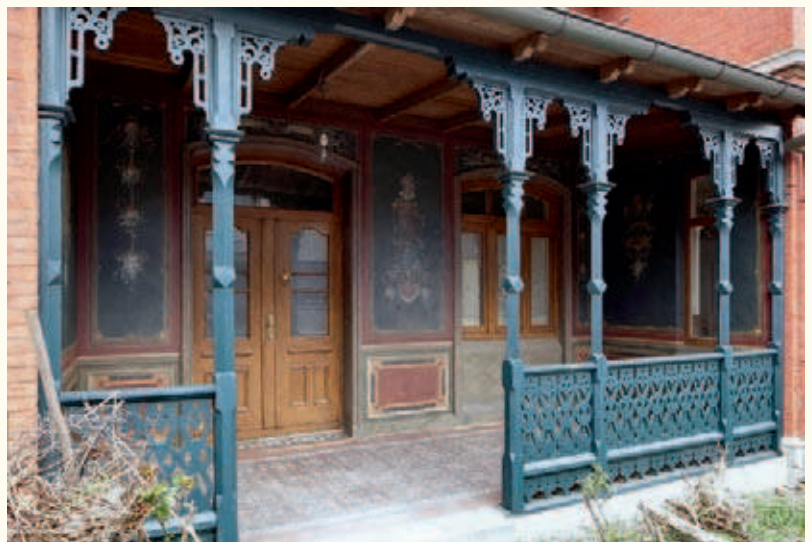
Blick in die Veranda nach Abschluss der Restaurierung.
