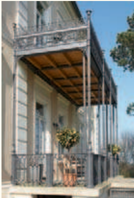
Restaurierter gusseiserner Vorbau an der Hauptfassade.
