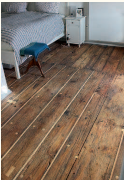
Löcher sorgfältig gepfropft, Fugen ausgespönt: der markante Alterswert wurde erhalten.
