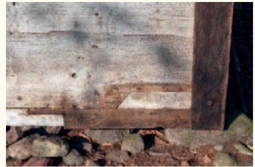
Detail aus dem Schwellenbereich.
