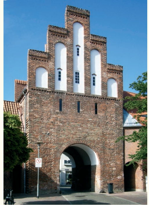
Tor nach der Sanierung (Feldseite).
