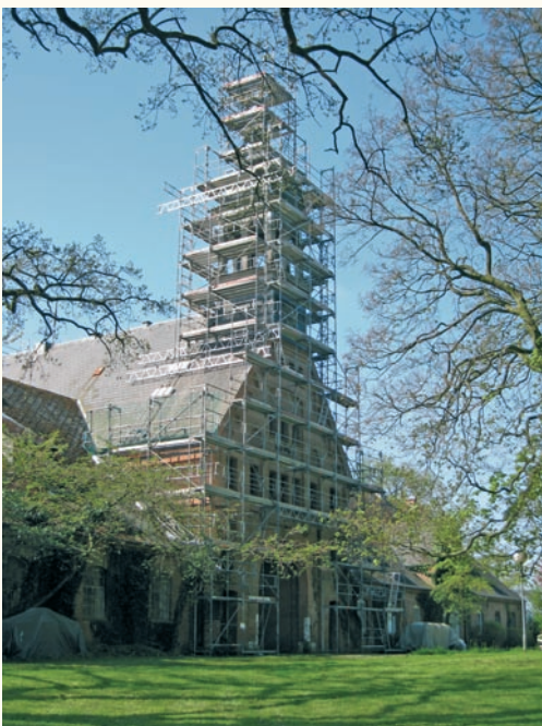
Das Torhaus während der Sanierung.
