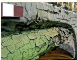
Starke Schwundrisse der farblichen Drittfassung (Foto Erdmann & Ahrends).
