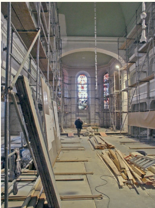
Bad Oldesloe, Kircheninneres während des Umbaus.
