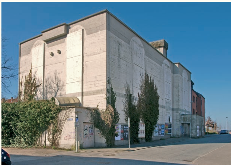
Im ehem. Luftschutzbunker am Eichenbergskamp soll ab 2011 die Computerschausammlung gezeigt werden.
