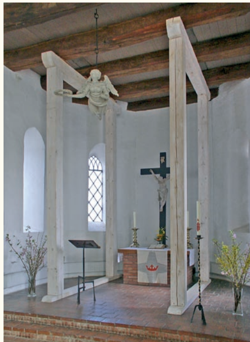
Die Notsicherung im Altarraum während der Kirchen-sanierung.
