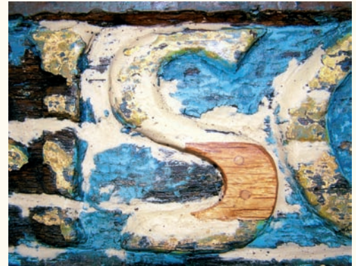
Schnitzergänzung aus Eichenholz und durch Kittung (Foto Erdmann & Ahrends).
