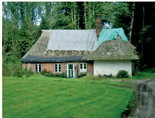
Das Gärtnerhaus mit dem Vorbau vor der Sanierung.
