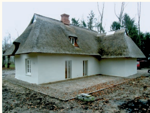
Blick auf das Gärtnerhaus nach der Sanierung.
