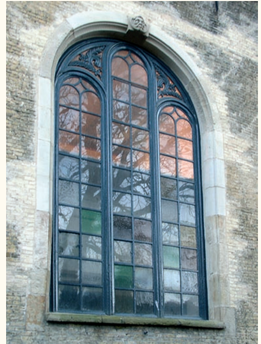
Fenster mit gusseiserner Maßwerkteilung und sandsteinernem Gewände nach der Restaurierung.
