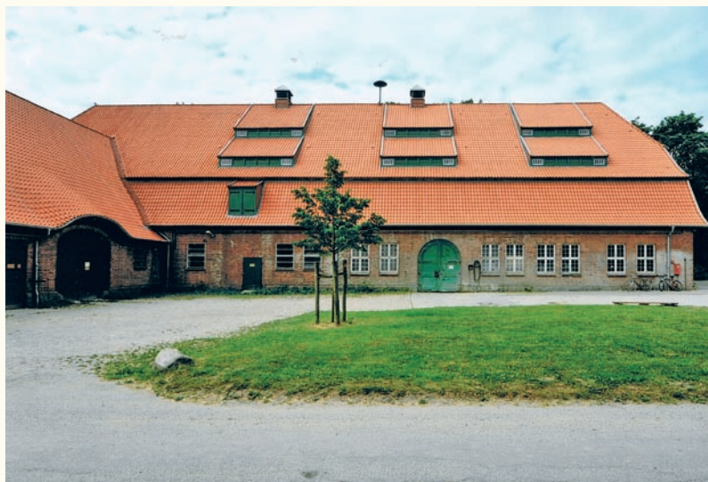
Die Dreiflügelanlage in Wulmenau neu eingedeckt mit Hohlziegeln im Farbton „Altbrandrot-Holstein“ (Foto A.K.A Ziegelgruppe).
