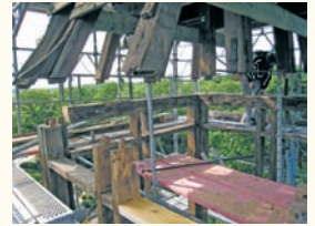
Der angehobene Turm.
