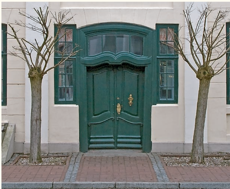
Haupteingang mit Oberlicht- tür.
