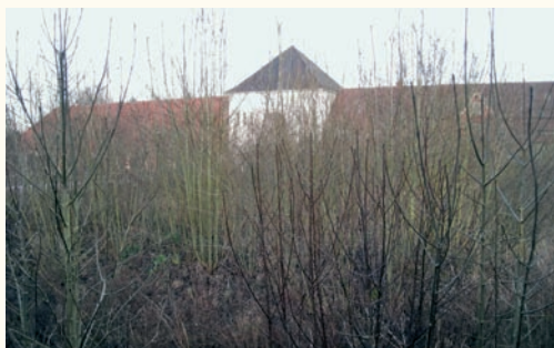
Vorherzustand des Hofplatzes mit Blick auf das Torhaus (Foto Holger Muhs).
