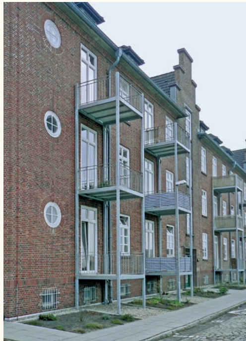
Kasernengebäude mit neuen, vorgestellten Balkonelementen.
