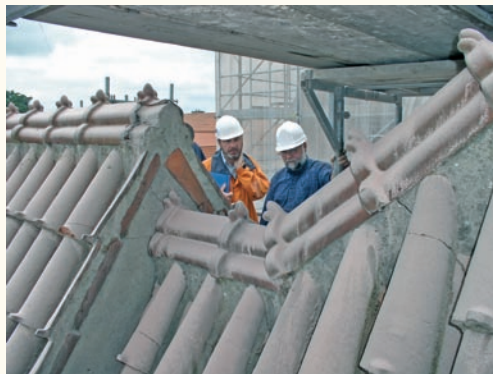
Baubesprechung vor der Mönch-Nonnen-Eindeckung des nördlichen Schwibbogens.
