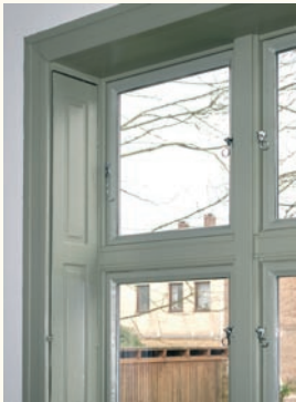
Sorgfältig detaillierte neue Fensterflügel ergänzen die ursprünglichen Blockzargen.
