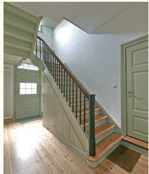
Erinnerungswert lebt aus dem Erhalt von Altersspuren – hier denjenigen der bauzeitlichen Treppe.
