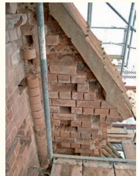
Mauerwerkssanierung mit Steinaustausch an einem Strebepfeiler.
