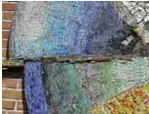
Ausschnitt des Mosaiks, das unterschiedliche Niveau der Einzelsegmente und Fehlstellen werden deutlich.
