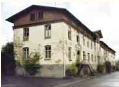
Ehemalige Admiralität in ruinösem Zustand.
