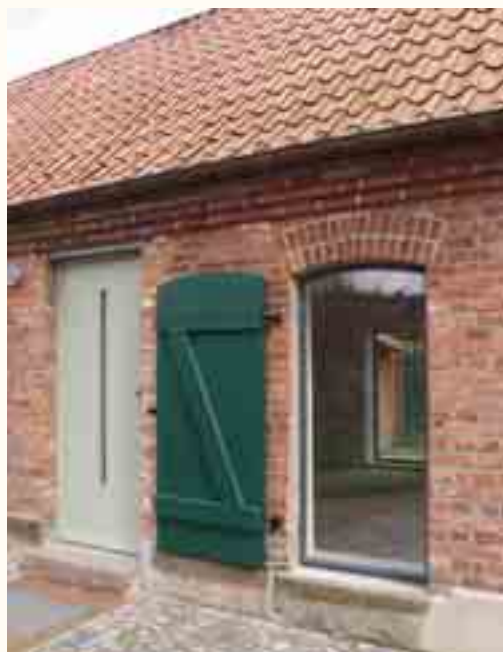
Die bodentiefen Luken erwiesen sich als ideale Lichtöffnungen, die neue Nutzung bildet sich mit der modernen Tür ab.
