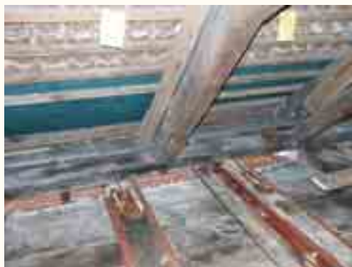
Sparren- und Balkenlage im Dachstuhl des Ursprungsbaus.
