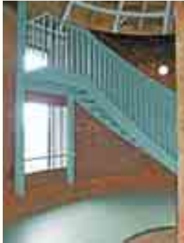
Blick in das erneuerte Treppenhaus.
