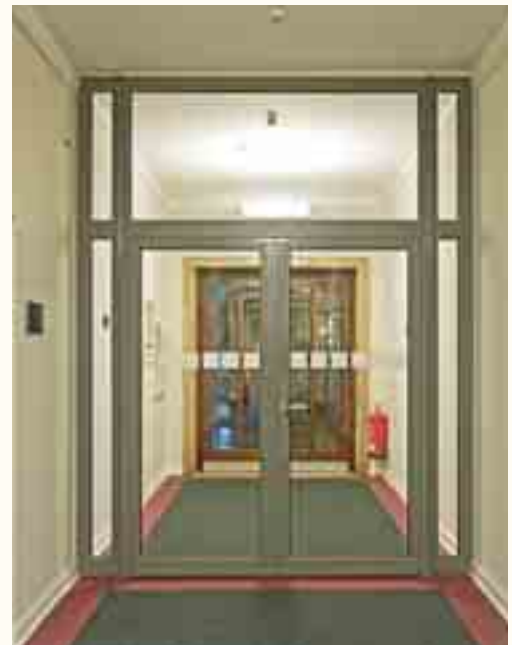
Neue Brandschutztür im Abstand zu den originalen Pendeltüren.
