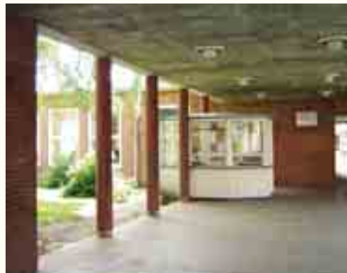
Milchhäuschen vor dem Umbau.
