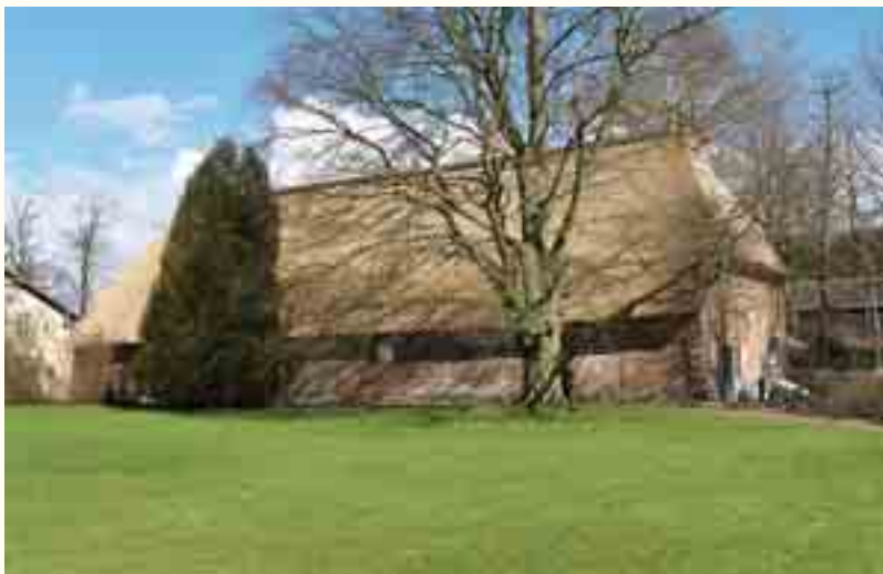
Sanierte Gerstenscheune auf Gut Bienebek.
