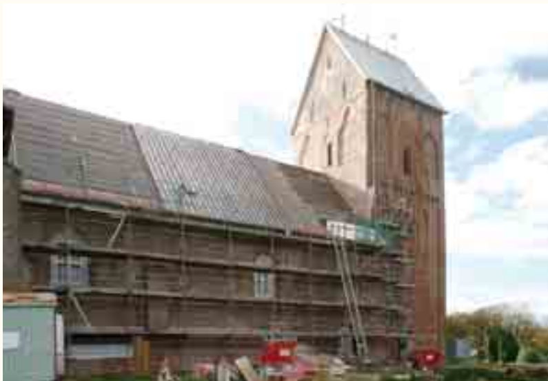
Ansicht von Nordosten nach der Mauerwerkssanierung und während der Neueindeckung mit Blei.
