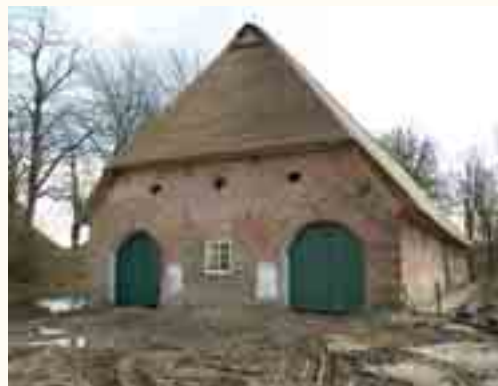
Giebel der Gerstenscheune.
