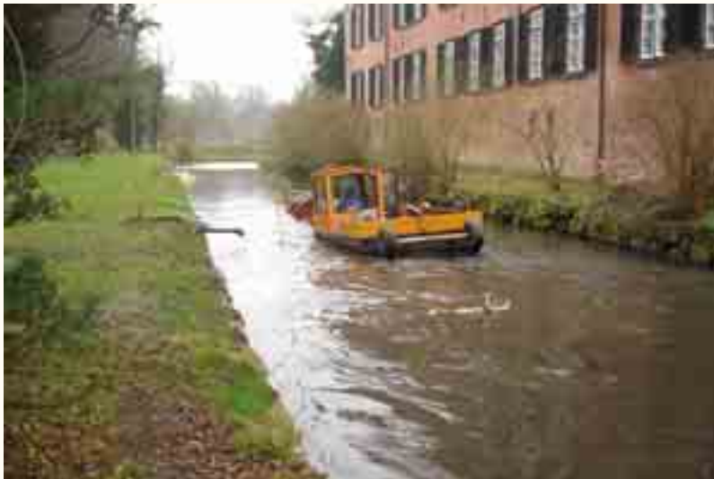
Der Schwimmbagger zur Grabenentschlammung im Einsatz.
