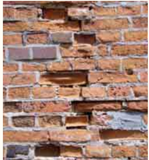
Die abgelösten Steinoberflächen zeigen das Ausmaß der Mauerwerksschäden vor der Sanierung.
