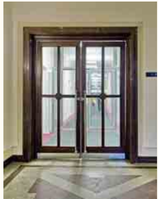
Pendeltüren wieder in originaler Oberflächenfarbgebung.
