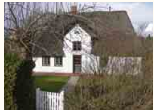
Blick vom Kirchhof auf das ehemalige Diakonathaus.
