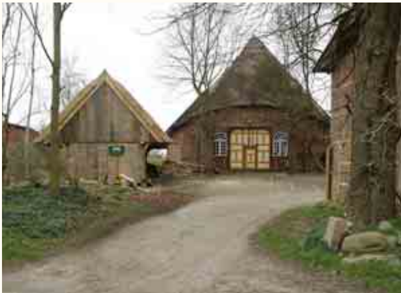
Der sanierte Bohlenspeicher auf Hof Wisch.
