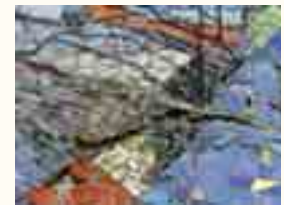
Schäden im Detail.
