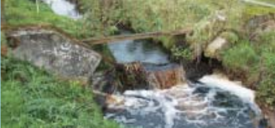
Sohlabsturz Dreckau Fotos: Matelski
