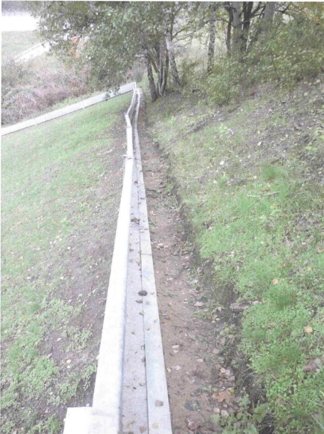
Abbildung 4: Massiver Reptilienschutzzaun optimiert mit einer in das Erdreich eingelassenen tiefgehenden Schiene (Stand Oktober 2019). Vergleiche mit Abbildung 5 in Protokoll zur Biologischen Baubegleitung Stand 28.02.2019.
