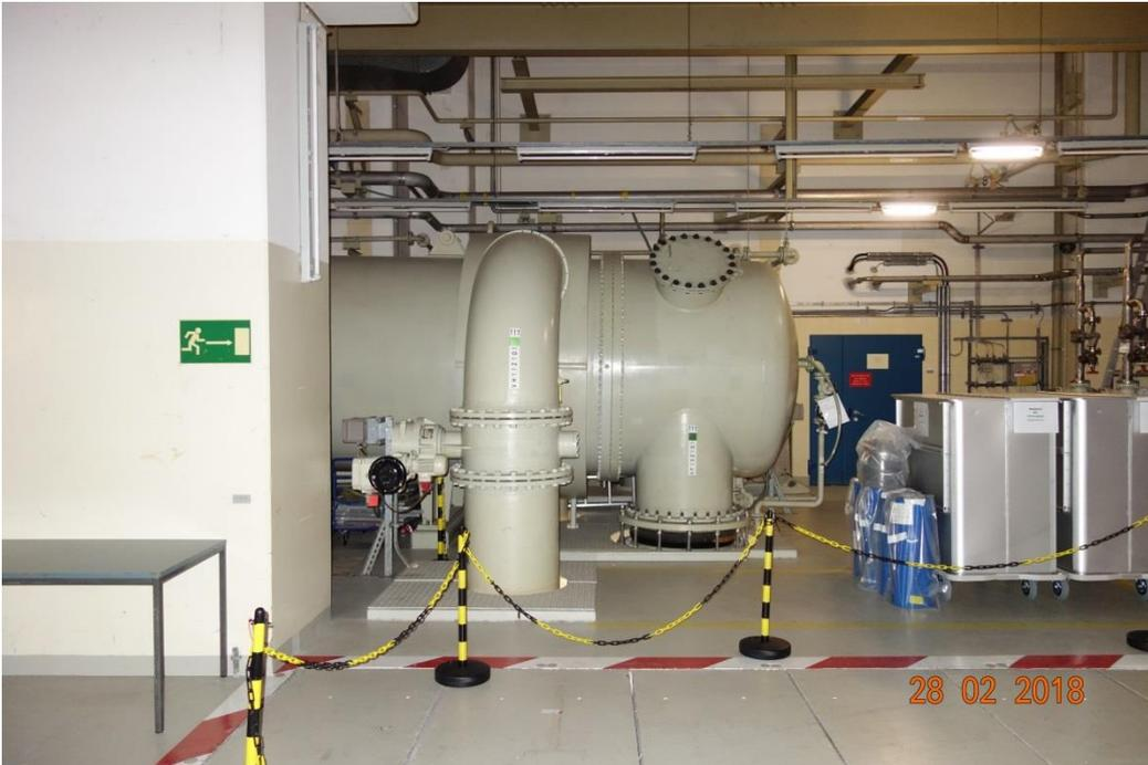
Abbildung 3-45: Zwischenkühler VF12B101 in Raum ZF02.73 auf Ebene + 8,50 m
