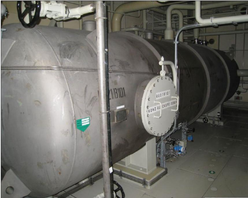
Abbildung 3-34: Kondensatrückspeisebehälter RU21B101 in Raum ZF01.73 auf der Ebene + 6,20 m
