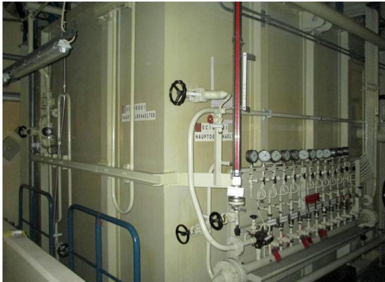
Abbildung 3-26: Hauptölbehälter in Raum F04.48 auf Ebene + 20,50 m
