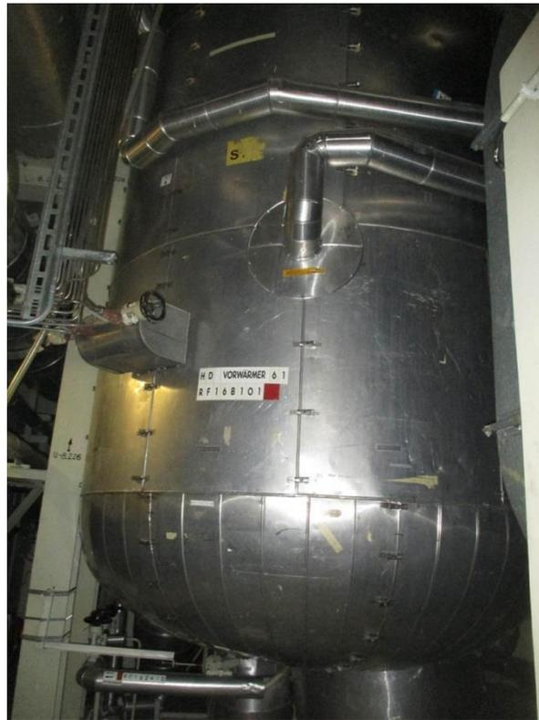
Abbildung 3-9: HD-Vorwärmer RF16 B101 in Raum F02.33 auf Ebene + 8,50 m
