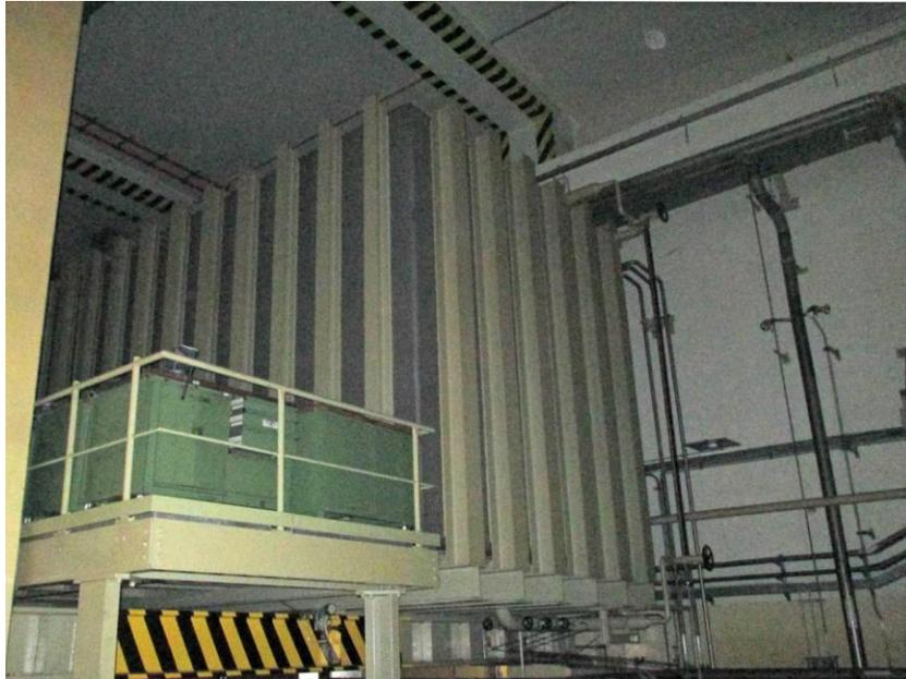
Abbildung 3-19: Kondensatvorratsbehälter auf dem Turbinenflur auf Ebene + 24,50 m
