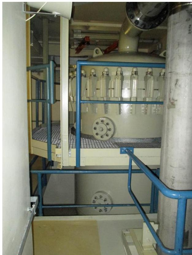
Abbildung 3-38: Anschwemmfilter UB81 B101 in Raum F03.67 auf Ebene + 14,70 m
