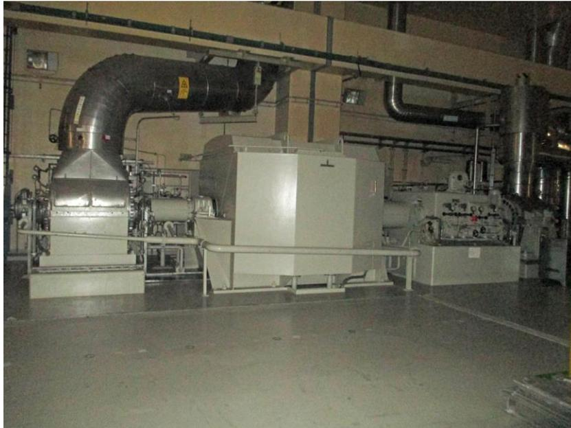
Abbildung 3-17: Reaktorspeisewasserpumpe RL33 D101 in Raum F02.43 auf Ebene + 8,50 m
