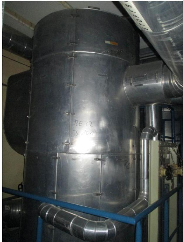
Abbildung 3-5: Stopfbuchsdampfzerzeuger in Raum F03.30 auf Ebene + 14,70 m
