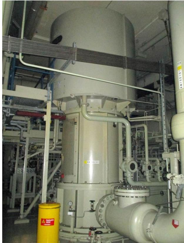
Abbildung 3-21: Hauptkondensatpumpe RM12D101 in Raum F01.51 auf Ebene + 1,20 m
