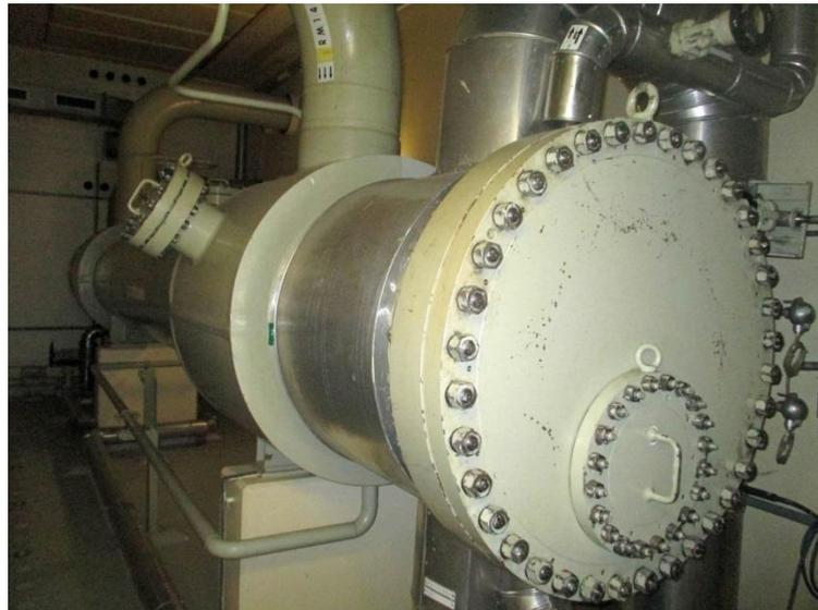
Abbildung 3-23: Kondensatkühler RN14 B101 in Raum F01.68 auf Ebene + 3,50 m
