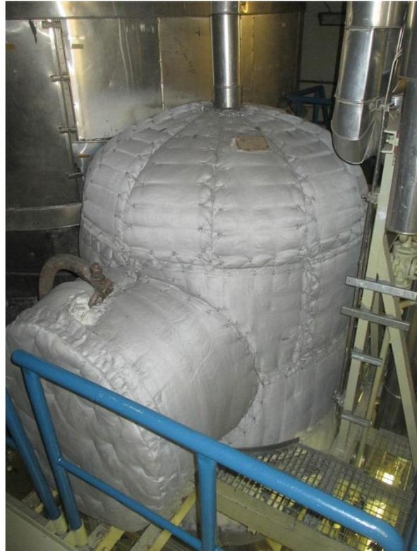
Abbildung 3-15: Kondensatbehälter RK12 B001 in Raum F02.37 auf Ebene + 8,50 m
