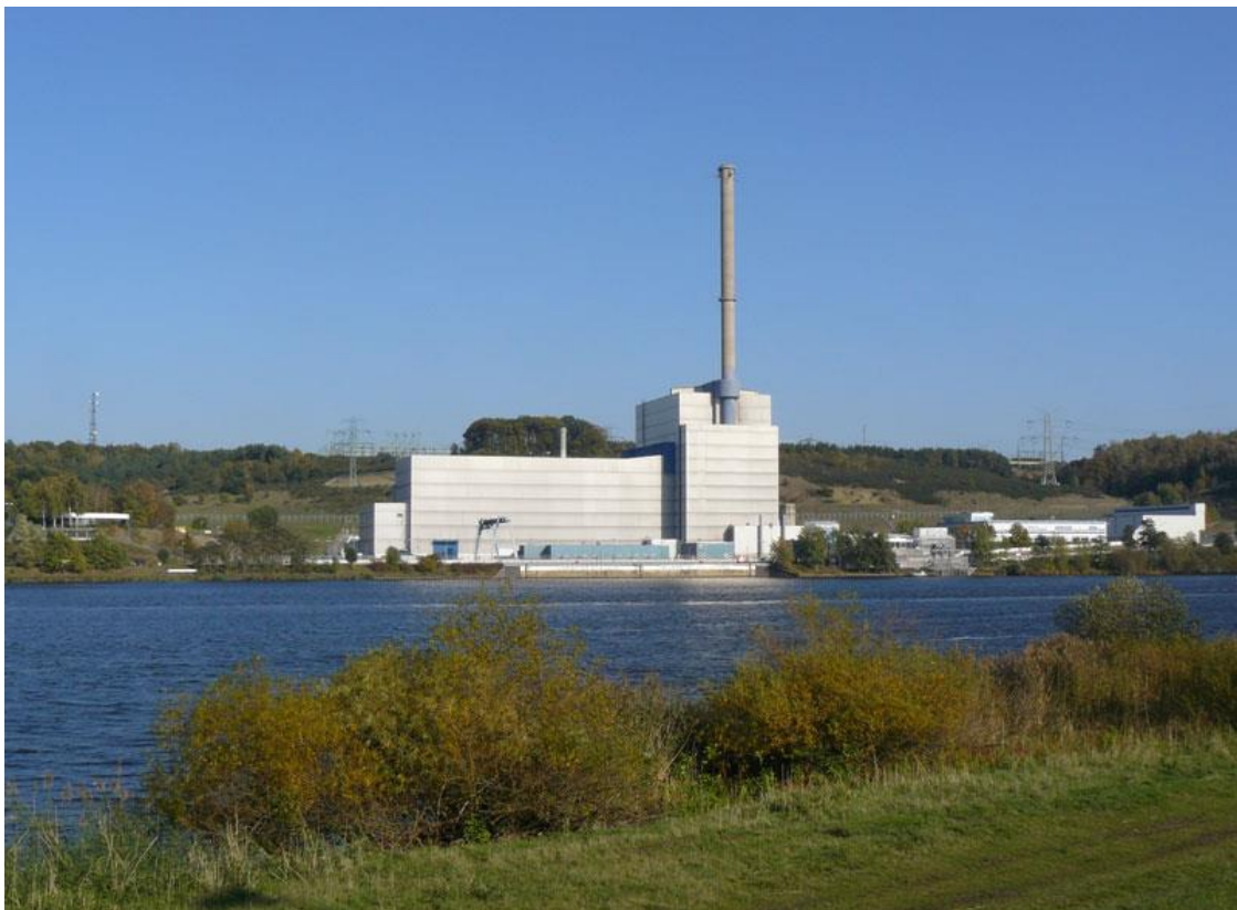
Abbildung 3-1: Kernkraftwerk Krümmel, Fotografie vom gegenüberliegenden Elbufer
