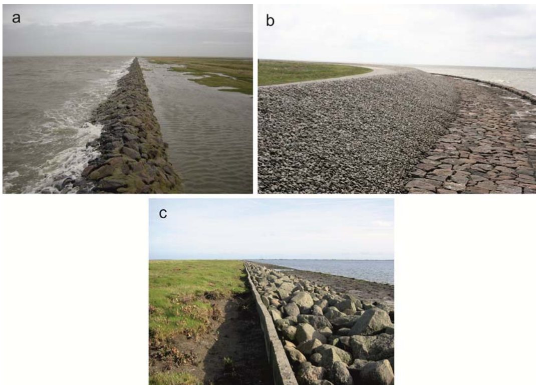
Abbildung 2-3: (a) Konservativer wasserdurchlässiger Raustreifen (Hallig-Igel) auf Nordstrandischmoor. Foto: Schindler 2011. (b) Moderner wasserdurchlässiger Raustreifen (Hallig-Igel) auf Langeneß. Schotter wird mittels eines Zwei-Komponenten-Klebers (Elastocoast®, BASF) zu einem Raustreifen modelliert. Dem Streifen vorgelagert ist ein wasserundurchlässiges Pflaster aus Basaltblöcken. Foto: Deicke 2014. (c) Alter Raustreifen auf Nordstrandischmoor. Das Niveau der binnenseitigen Salzmarsh wächst über die Höhe des Raustreifens hinaus. Foto: Schindler 2012.
