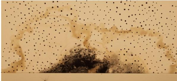
Abb. 1: Schimmelbildung an einer Deckenverkleidung
