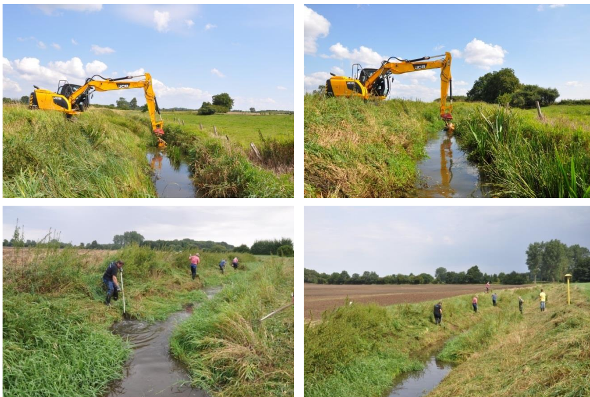
Abb. G5: Schonende GU in 2013: An den Pilotgewässern Eider und Linau sind die Unterhaltungswechsel gut sichtbar und die wechselseitig entstandenen uferparallelen Röhrichtbänke wurden weiter geschont.
