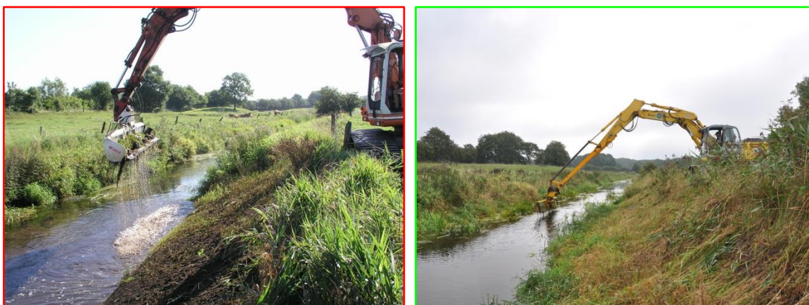
Abb. 12: Treene: links GU bis 2009: einseitige Böschungs- und komplette Sohlmahd - rechts GU ab 2010: wechselseitiges Krauten der Sohle und abschnittsweise Böschungsmahd auf der Arbeitsseite
