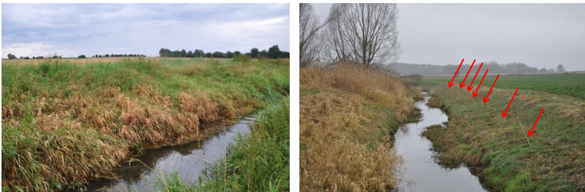
Abb. 8: Pilotstrecke Linau: abgängige Ufervegetation im Sommer 2011 (links) - rechts Längsbänke (03/2014), die sich durch die wechselseitige Unterhaltung entwickelt haben und Kennzeichnung von aus dem angrenzenden Acker kommenden Dränagen (rote Pfeile)
