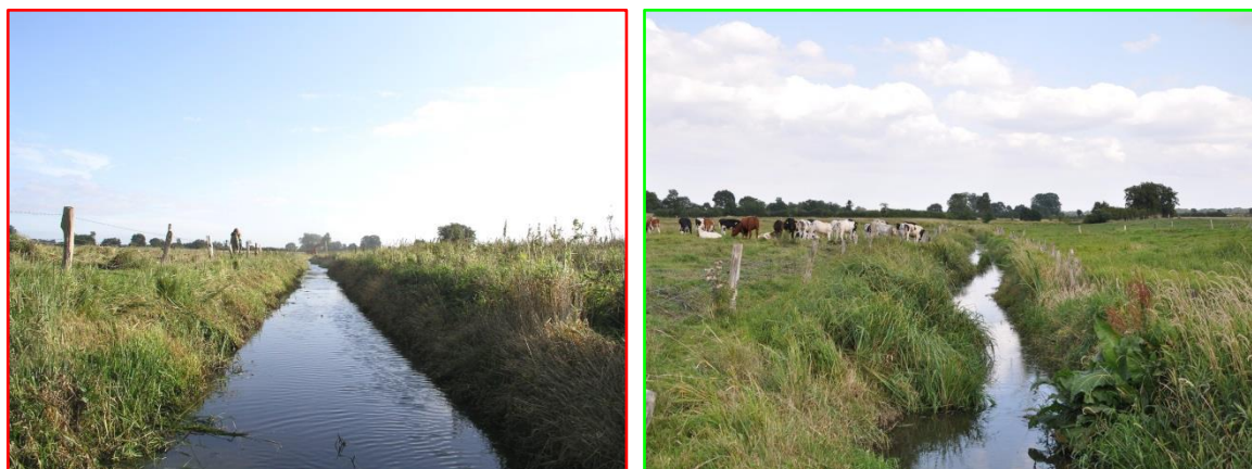
Abb. 13: Eider: links GU bis 2009: beidseitige Böschungs- und komplette Sohlmahd in einem Arbeitsgang - rechts GU ab 2010: durch wechselseitiges Krauten der Sohle mit abschnittsweiser Böschungsmahd auf der Arbeitsseite hat sich ein schlängelnder Stromstrich entwickelt
