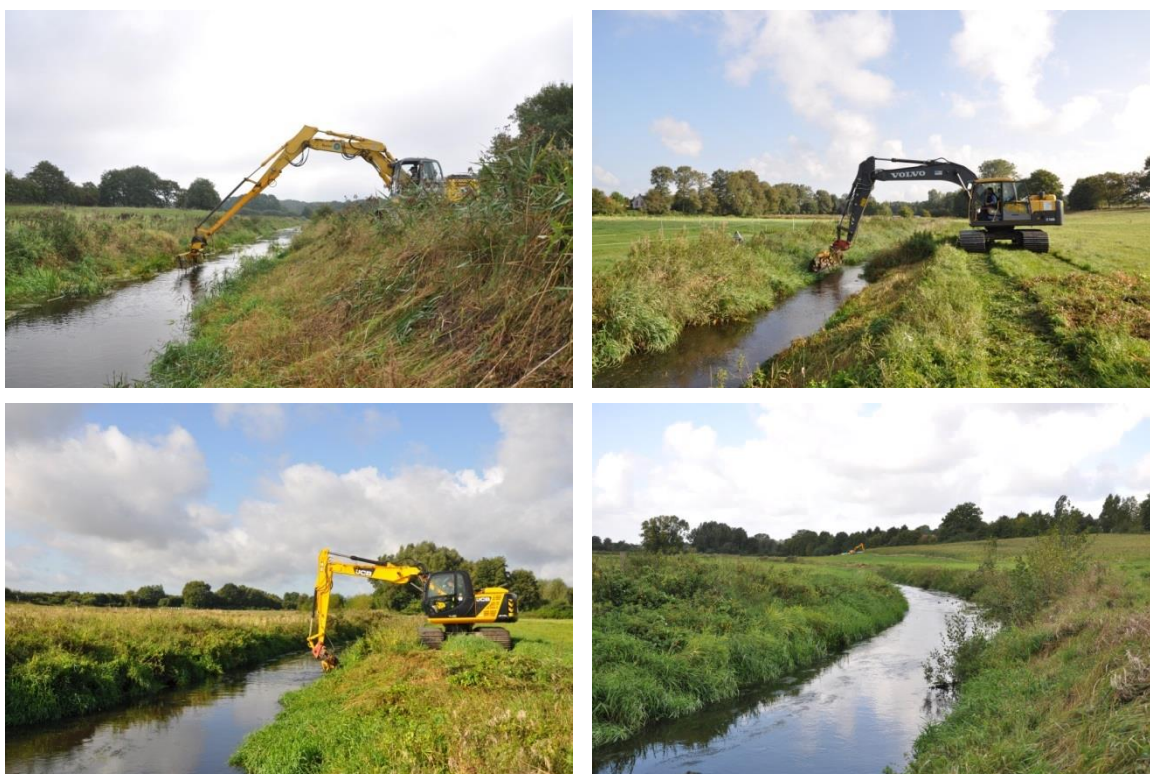
Abb. G4: Schonende GU in 2013: Pilotgewässer Treene beim Krauten der Sohle ab der Mitte (oben links) sowie Mühlenbarbecker Au (oben rechts) und Beste, wo die Böschungsfüße auf beiden Uferseiten geschont wurden. An der Beste wurden außerdem die aufkommenden Gehölze von der Mahd ausgenommen. (unten rechts).
