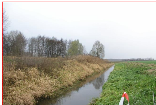
nach herkömmlicher GU - Aug. 2009 - Blick gewässeraufwärts
