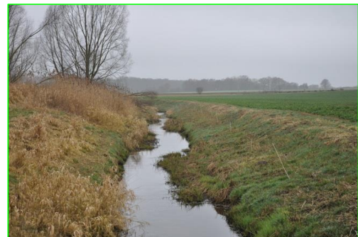
nach schonender GU - Aug. 2013 - Blick gewässeraufwärts
