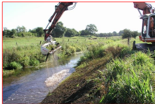
nach herkömmlicher GU - Aug. 2009 - Blick gewässeraufwärts
