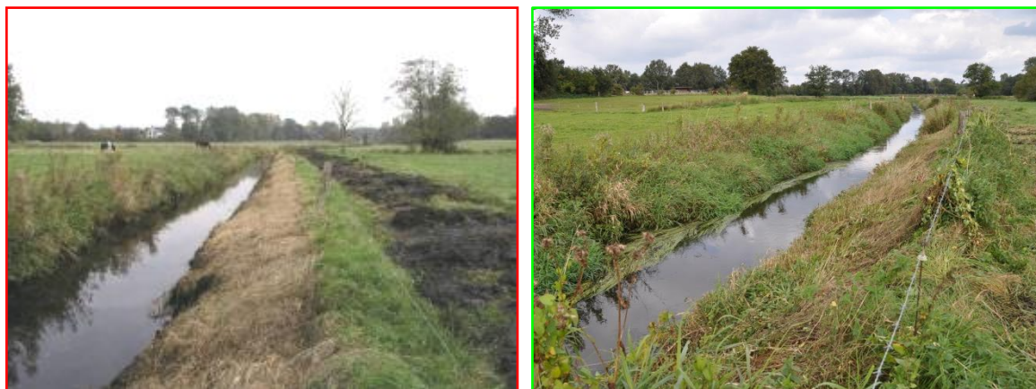
Abb. 14: Mühlenbarbeker Au: links GU bis 2009: einseitige Böschungsmahd (Schlegeln) und komplette Sohlräumung - rechts GU ab 2010: wechselseitiges Krauten der Sohle und abschnittsweise Böschungsmahd auf der Arbeitsseite
