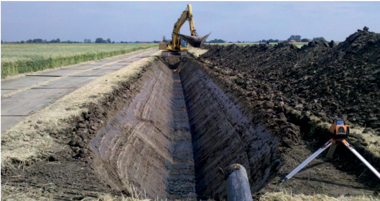
Abbildung 4: Ausheben eines Leitungsgrabens in einer Kalkmarsch
