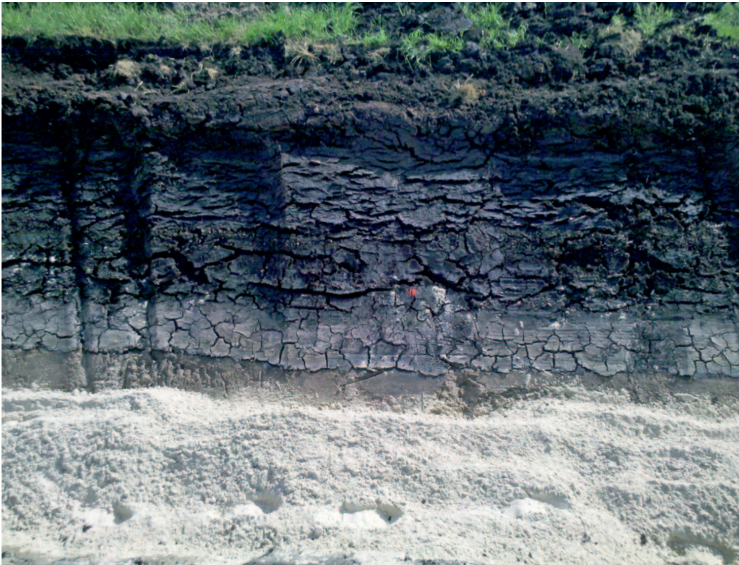
Abbildung 7: Rissbildung und Schrumpfung infolge der Belüftung von Torfen im Leitungsgraben
