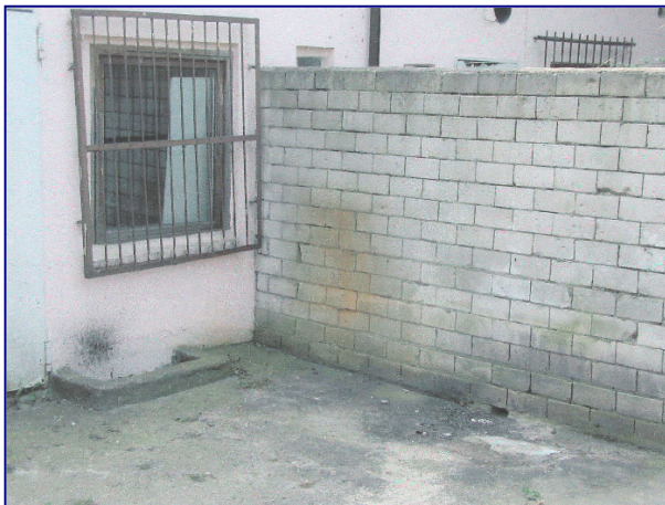
Möglicher Lagerplatz von Reinigungsmitteln
