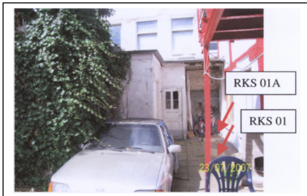
Blick auf ehem. Benzinwäscherei
