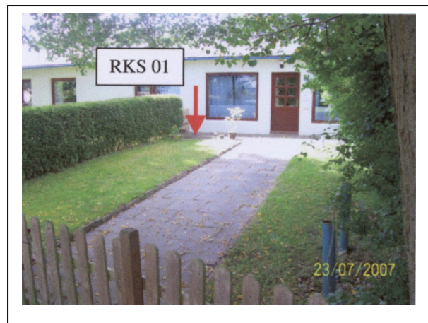
Vorderseite Gebäude, Lage RKS 01
