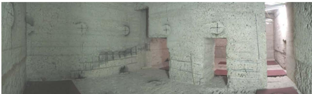
Abbildung 4: Dekontaminierte Gebäudestrukturen
