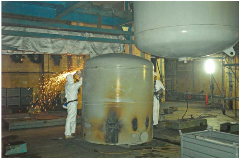
Abbildung 8: Abbau und Zerlegung von Behältern
