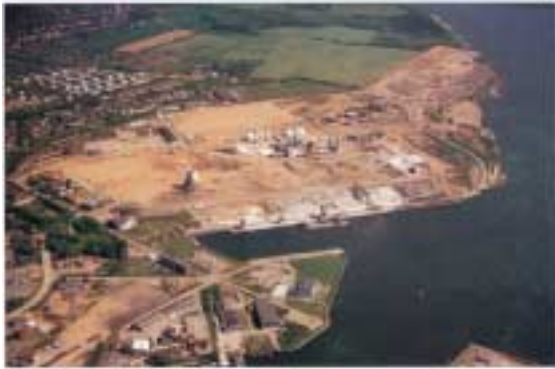
Metallhüttengelände (1998) Photo: WCI Umwelttechnik
