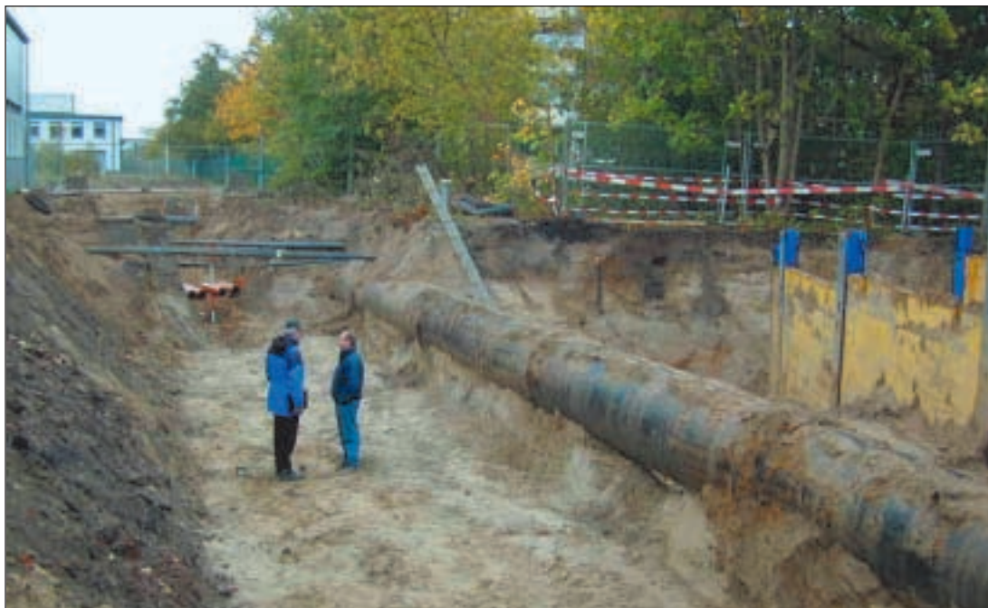
Abbildung 11: Technik zu Beginn des 20. Jahrhun- derts – 1.000er Gasleitung aus Stahlguss
