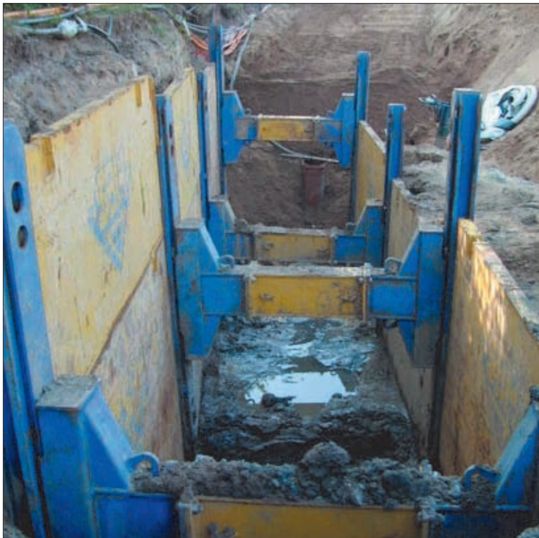
Abbildung 10: Aushub mit Ver- baukästen
