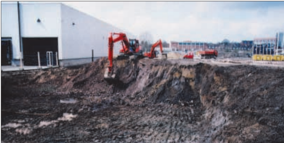
Abbildung 9: Aushub der Säuregruben
