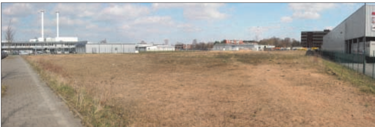
Abbildung 15: Saniert und erschlossen: südliche Teilfläche unter nordöstlichem Blickwinkel
