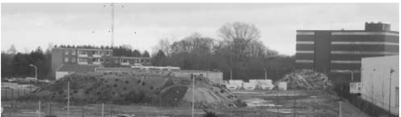
Abbildung 5: Abgeplante Halden vor Sanierungsbeginn 2001
