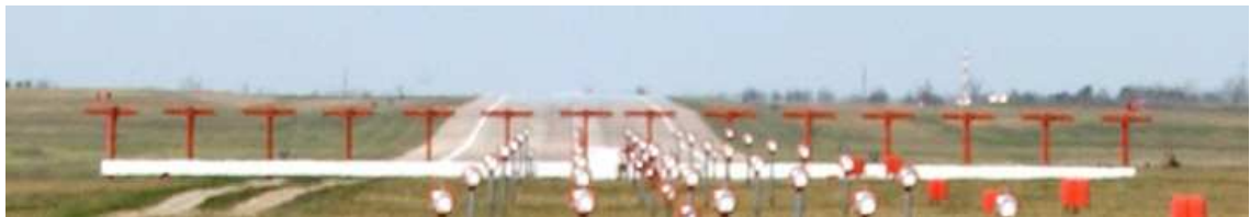
Abbildung 3-28: Localizer Antenne
