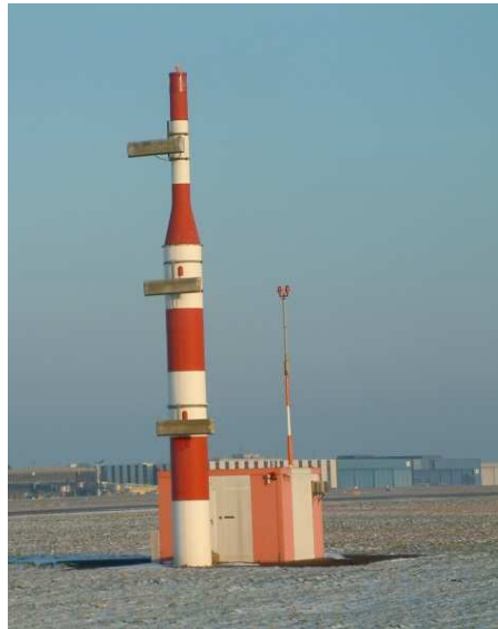
Abbildung 3-27: Glideslope Antenne
