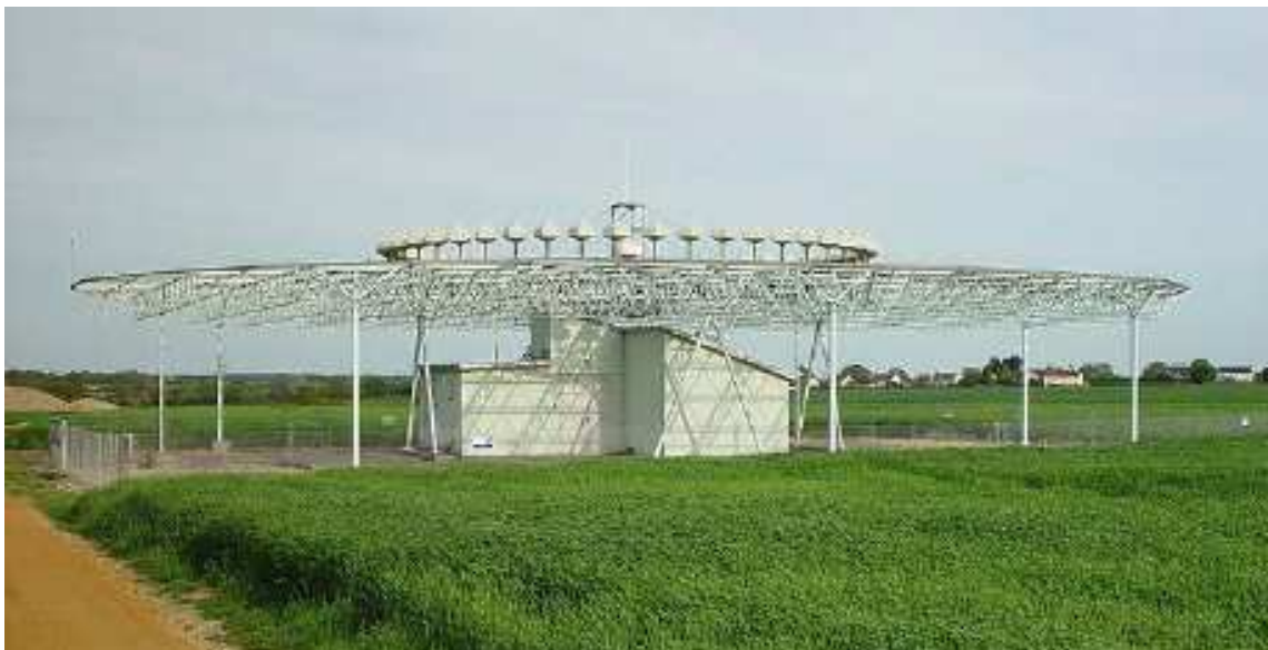
Abbildung 3-8: Abb. 6.13. Antennenanlage eines DVOR
