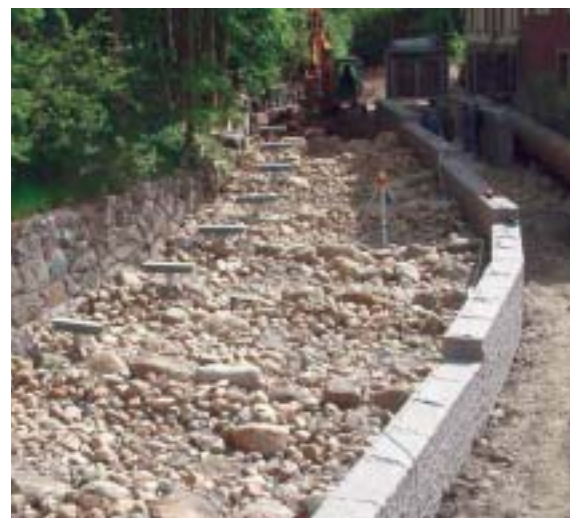
Die neue Sohlgleite im Bau
