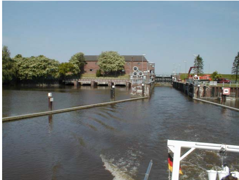
Abb. 2-9: Eider, Schleuse bei Nordfeld
