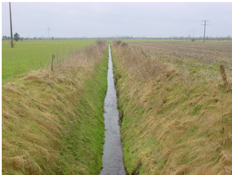
Abb. 2-11: Begradigtes und querschnittsverändertes Gewässer
