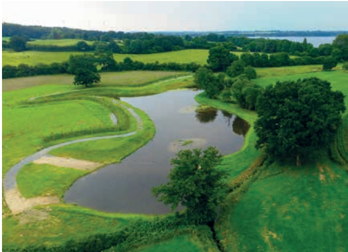
Das Retentionsbecken am Hauptzulauf des Wittensees soll Nährstoffe aus der Mühlenbek zurückhalten
