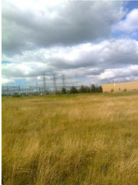
Abbildung 5.2-1: Verwilderte Industriefläche/zukünftige Baufläche LasmA mit Blickrichtung Nord-Westen zum Umspannwerk
