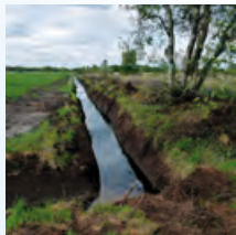
Moore werden auch heute noch entwässert, um angrenzende Flächen besser nutzen zu können. Bei der Räumung vertiefte Gräben verstärken die Moorsackungen.
