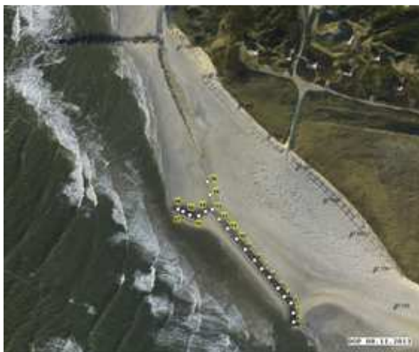
Abb. 1: Kontrollpunkte Tetrapoden Wellenbrecher Hörnum-Odde LKN-SH (14.01.2014)
