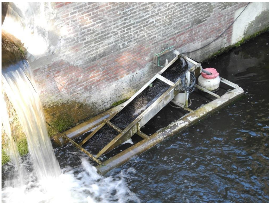
Abbildung 5: Aalfalle der Firma KÖTHKE in der ehemaligen Schleuse Kluvensiek
