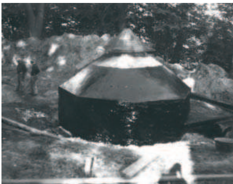
5 Die Aufnahme zeigt die 1964 mit einer Betonschicht mit Ceresitzusatz und Maschen-drahteinlage überzogene und nach Erhärtung zweimal mit einem Isolieranstrich versehene Grotte.
