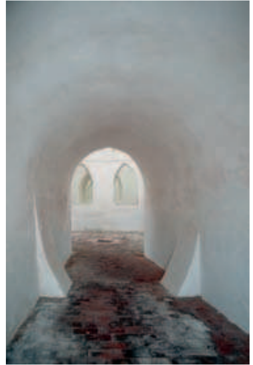
10 Heutiger Hauptzugang (nördlicher Gang) zur Grotte.
