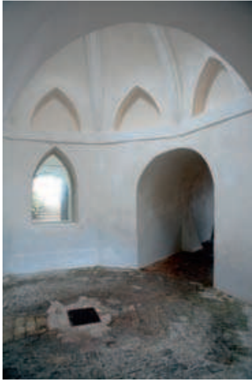
9 Grotte mit Bodenabfluss und dem nördlichen Hauptzugang.
