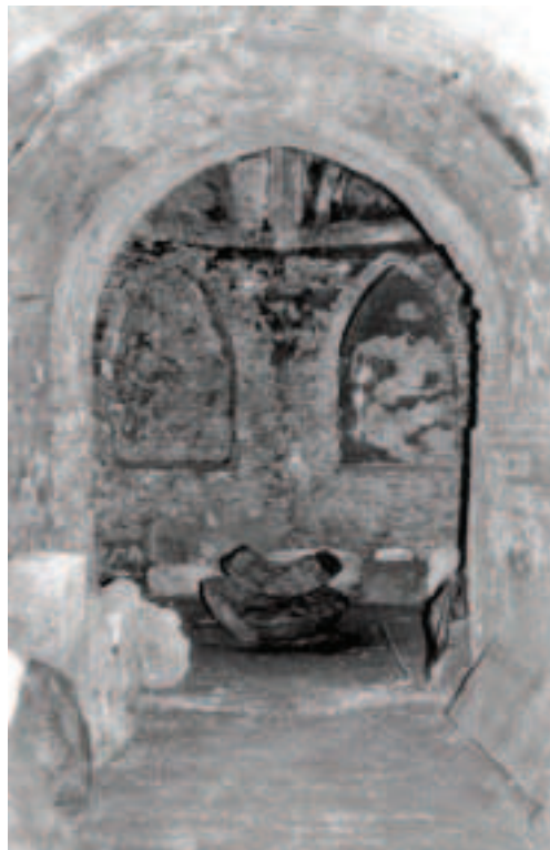
3 Zugang zur Grotte durch den nördlichen Gang, Aufnahme 1964.
